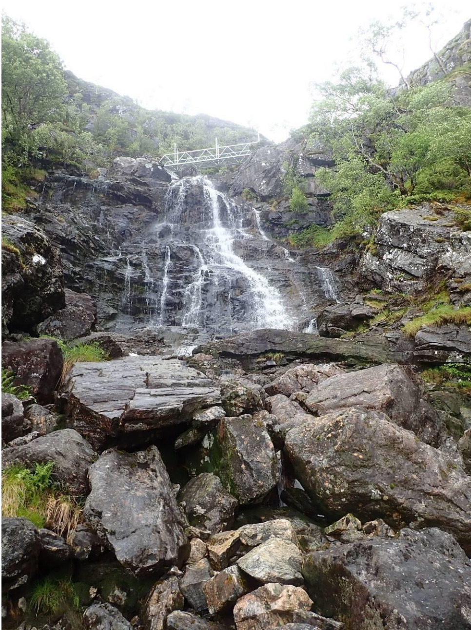
Figur 13 Tysseelva, bilde tatt ved kote 400. Overføringstunellen er stengt på bilde. Det er noe lekkasjevann.
