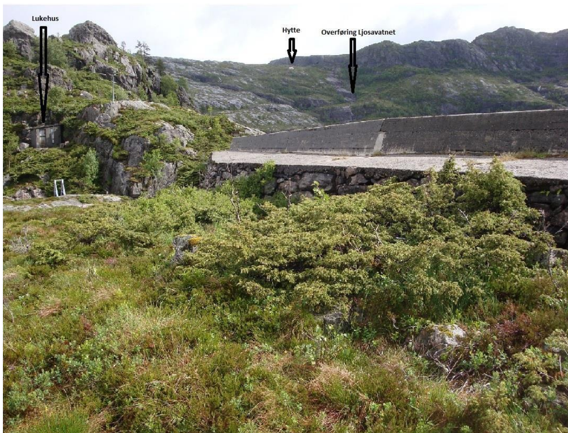
Figur 4 Dam Øvre Botnevatn. Lukehus, tapping fra Ljosavatn og privat hytte er med på bildet.
