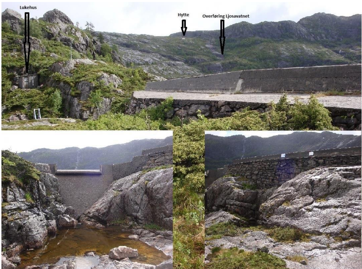
Figur 2-3 Dam Øvre Botnevatn
