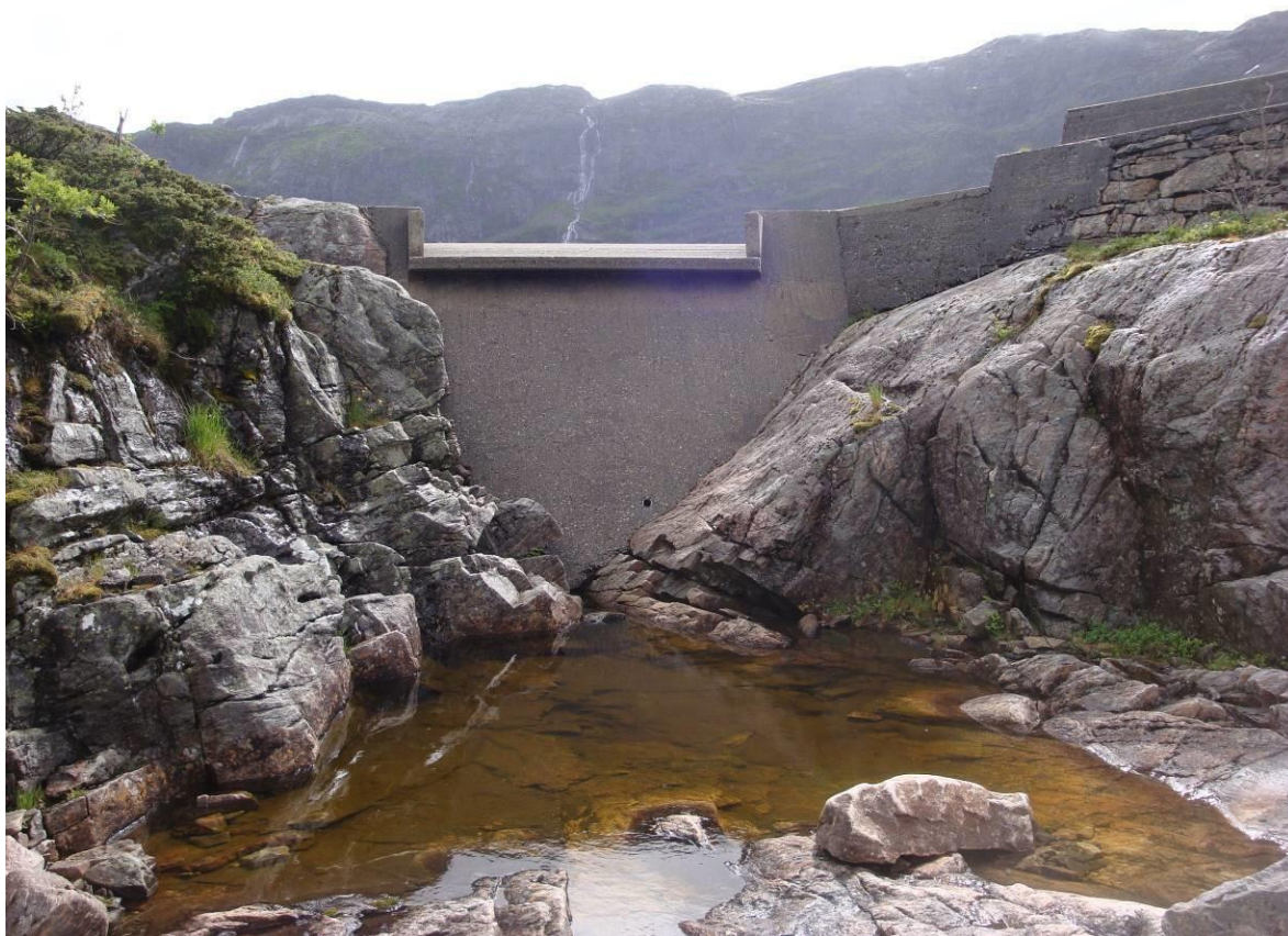
Figur 9 Overløp Dam Øvre Botnevatn.
