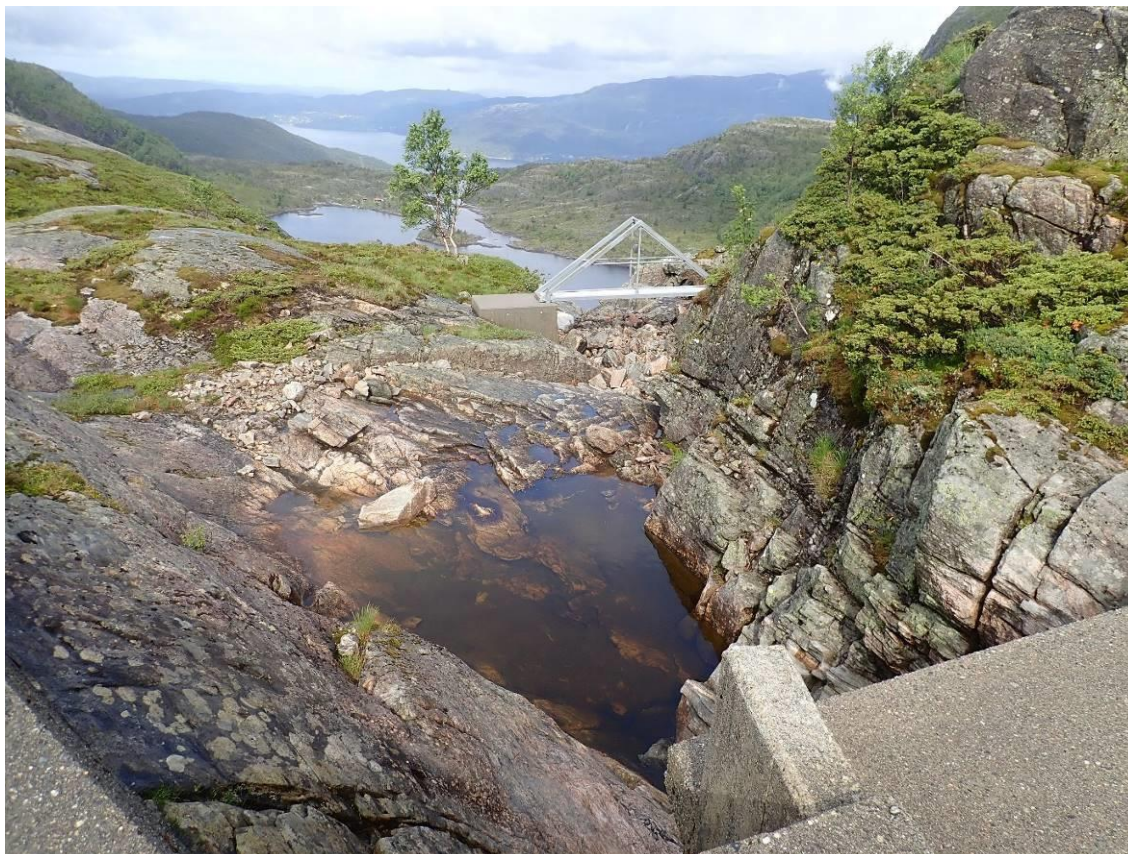
Figur 7 Tysseelva. Bildet er tatt fra demningen på Øvre Botnevatn og ned mot Nedre Botnevatn.
