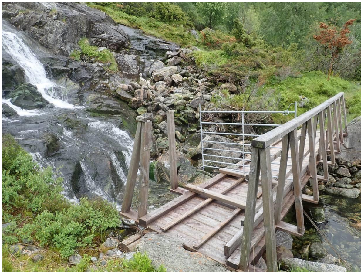
Figur 16 Gangbru over Tysseelva like oppstrøms utløpet i Nedre Botnevatn.
