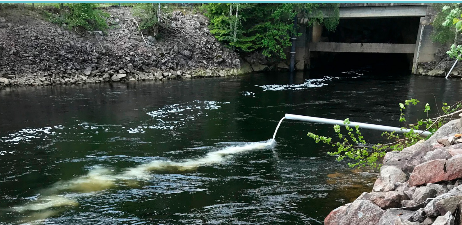
Vannstrålen som holder liv i elva – fra Håverstad kalkdoseringsanlegg. Foto: Torbjørn Forseth
