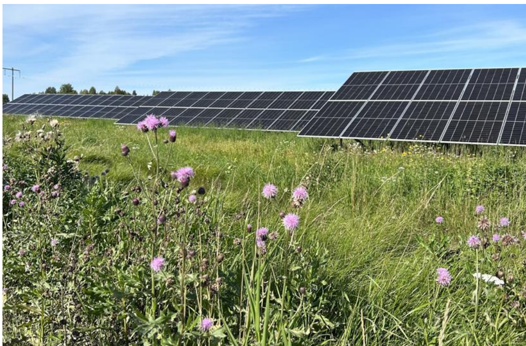
Figur 22 - Vegetasjon i solkraftverk sommeren etter bygging
