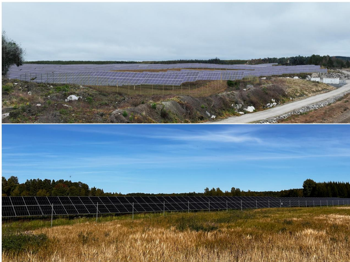
Figur 9 - Inngjerding av solkraftverk
