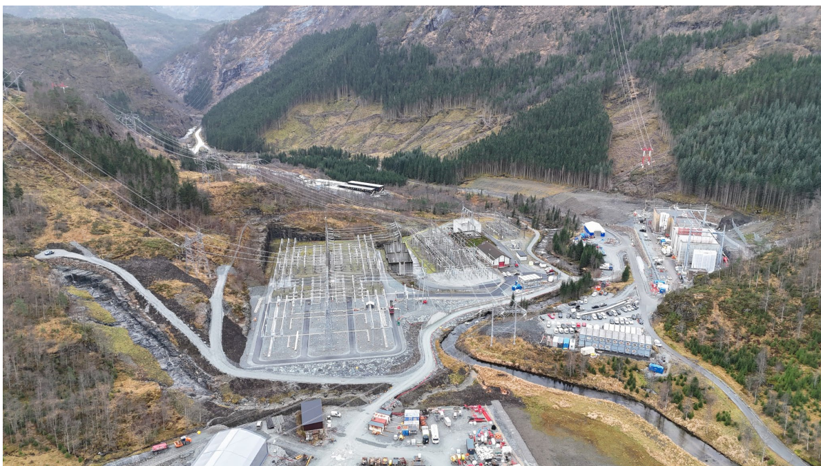
Figur 3-29 Nedre/sørlig del av Børdalen preges av inngrep tilknyttet industri. Dronefoto: Sweco, 10.11.2025.
