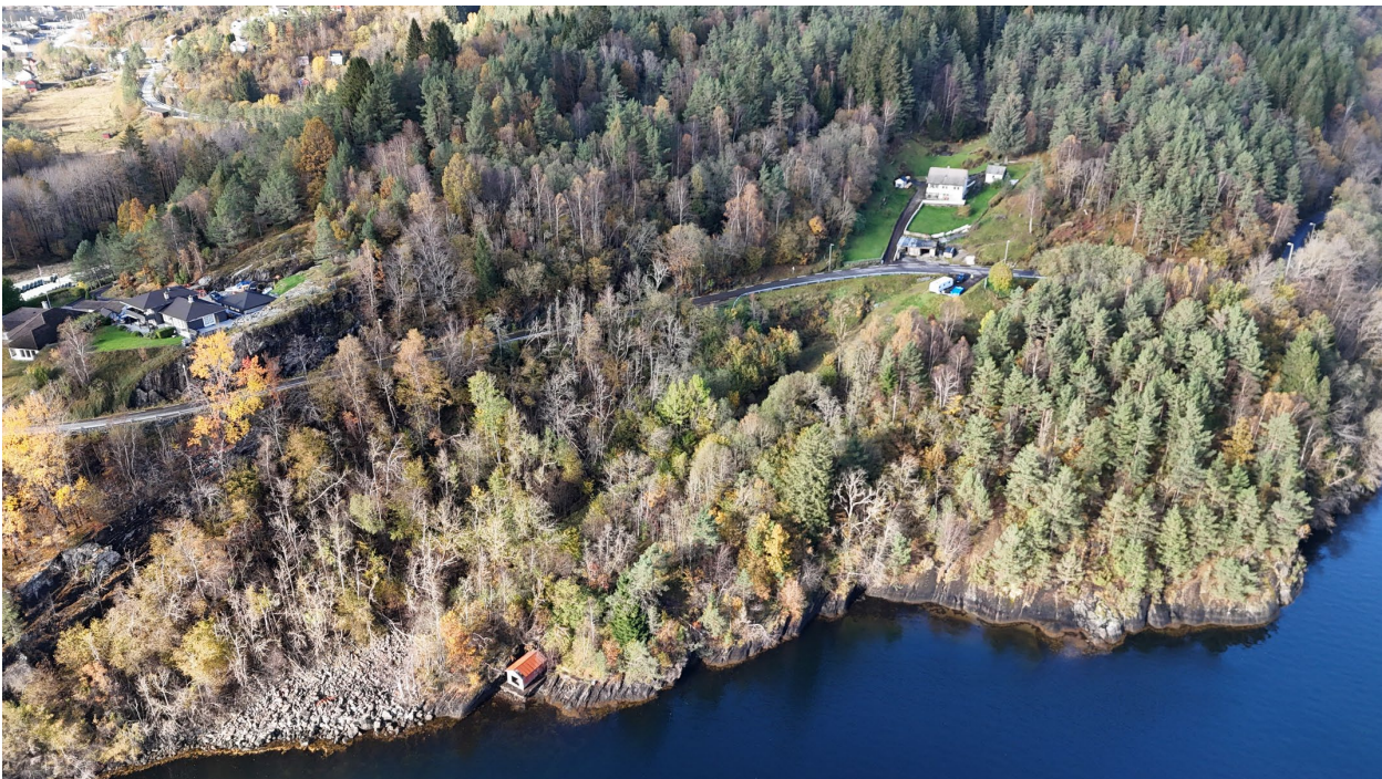
Figur 3-58 Sørvestlig tupp av Haukaneset. Dronefoto: Sweco, 16.10.2025
