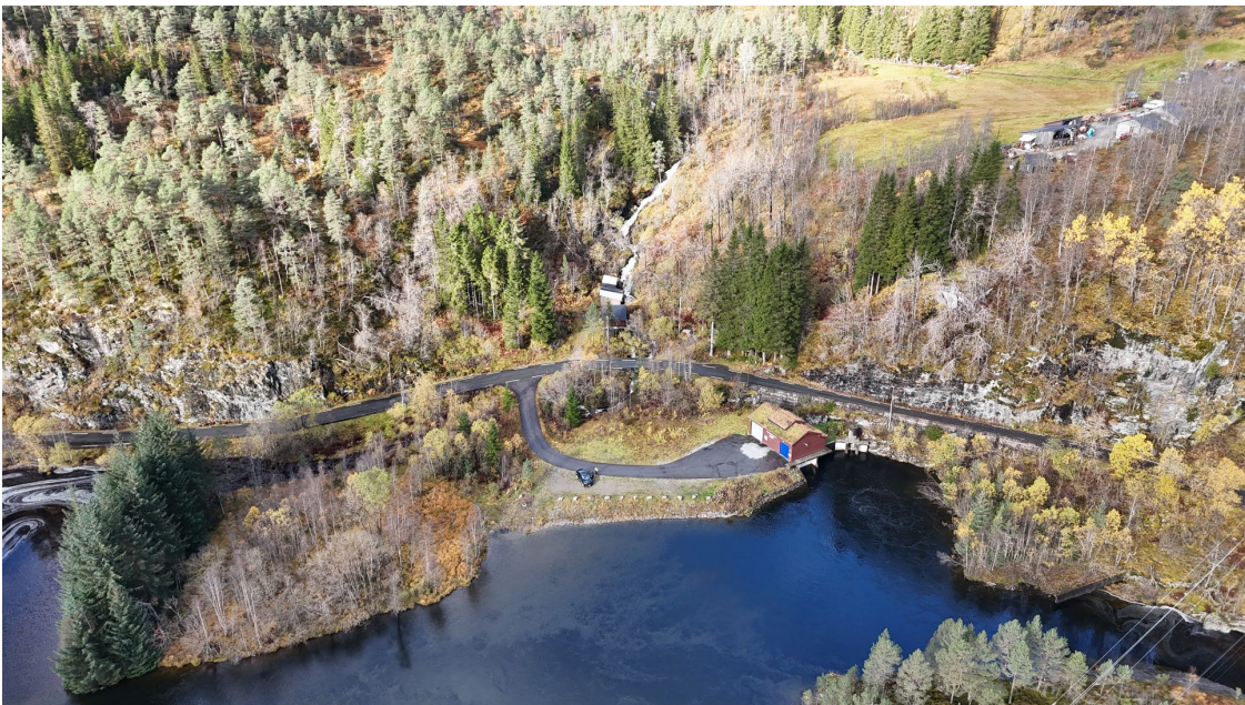
Figur 3-23 Myra kraftverk, rødbrunlig bygg ved Fiskevatnet. Dronefoto: Sweco, 16.10.2025.
