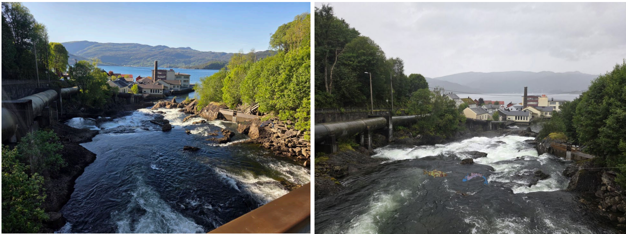
Figur 3-62: Bilde til venstre, tatt 19.05.2024 viser vannføring målt 7,2 m 3 /s. Bilde til høyre, tatt 04.08.2025 viser vannføring målt 15,0 m 3 /s. Foto: Sweco.
