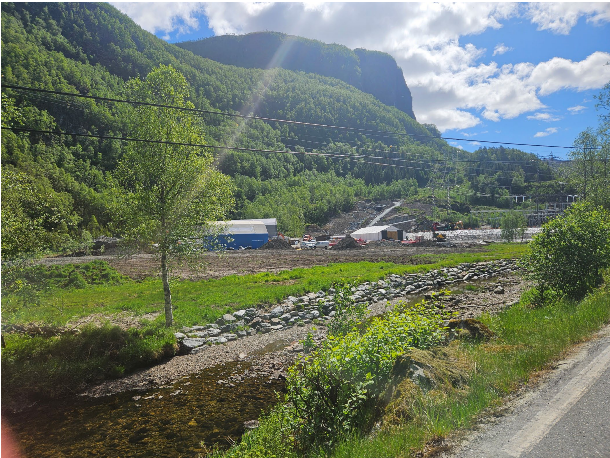
Figur 3-32 Nord for Samnanger transformatorstasjon. Foto: Sweco, 26.05.2025.
