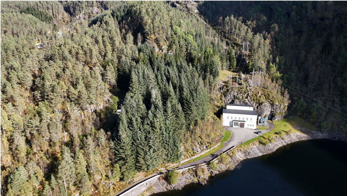
Figur 3-22 Grønsdal kraftverk. Dronefoto: Sweco, 25.09.2025.
