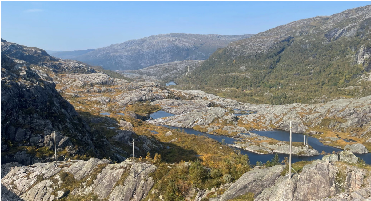
Figur 3-14 Fra demning ved Svartavatnet retning innover Sotabotnen. Foto: Sweco, 05.09.2024
