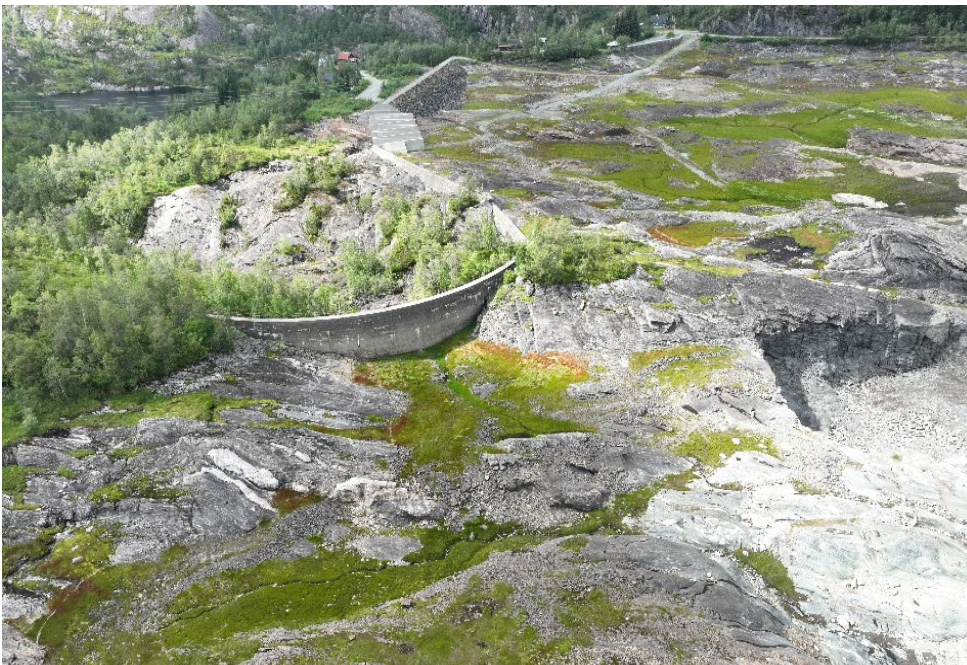
Figur 3-9 Nedtappet situasjon. Bilde tatt mot mur og labyrintoverløp i sørvest. Dronefoto: Sweco, 12.07.2024.
