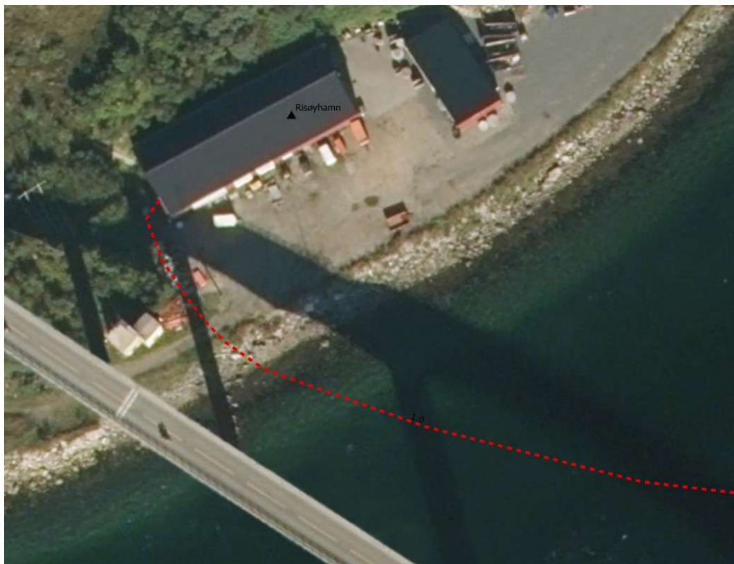
Figur 2-5: Landtaket på ved Risøyhamn med transformatorstasjonen i bakgrunnen.
