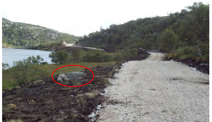
Figur 4-3 Eksempel på istandsetting av fylling med innslag av stein, foto: HEV
