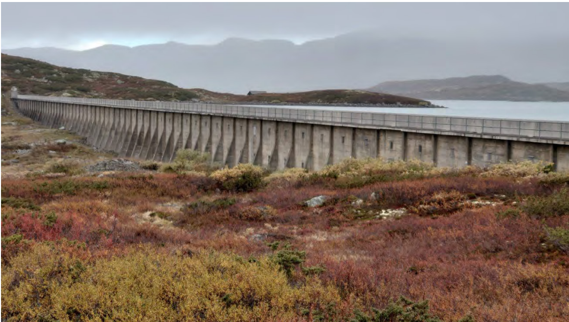
Figur 3-2 Eksisterende platedam rives etter at ny dam er ferdigstilt.
