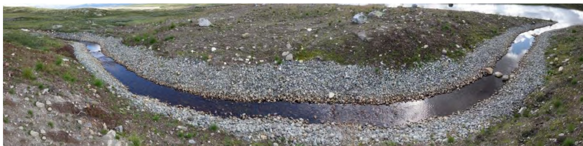
Figur 17. Inn- og utløpsbekker i Bruddtjern ble plastret med kult for å stabilisere bekkeløpet.
