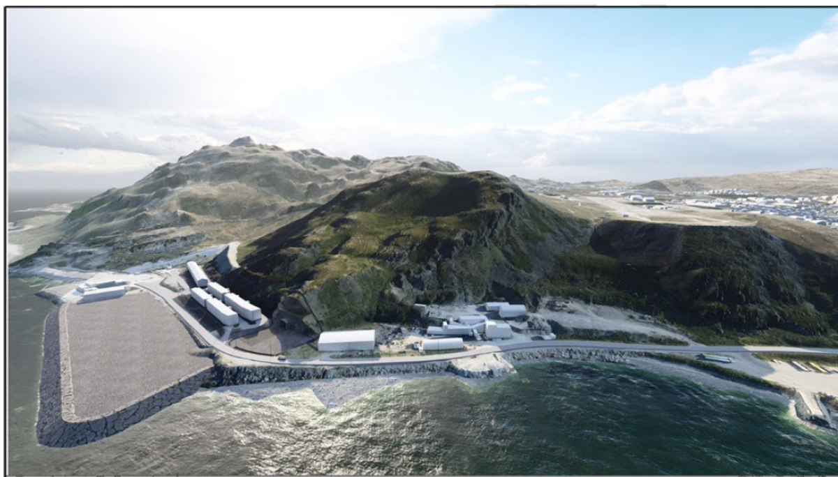
Figur 13. Alternativt massedeponi på Meland som er en del av Equinor sitt prosjekt for elektrifisering av gassanlegget på Melkøya. Utsnitt fra Equinor sin detaljplan for elektrifisering av Hammerfest LNG.
