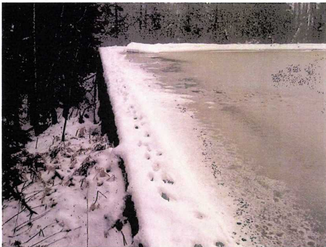
Midtre Askdam, desember 2009. Dypål og lavbrekk ved overløp.
