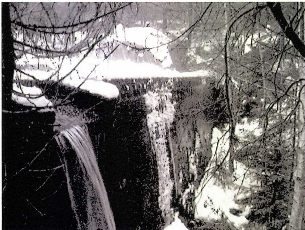
Øvre Askdam, desember 2009. Overløp og dam i dyplop
