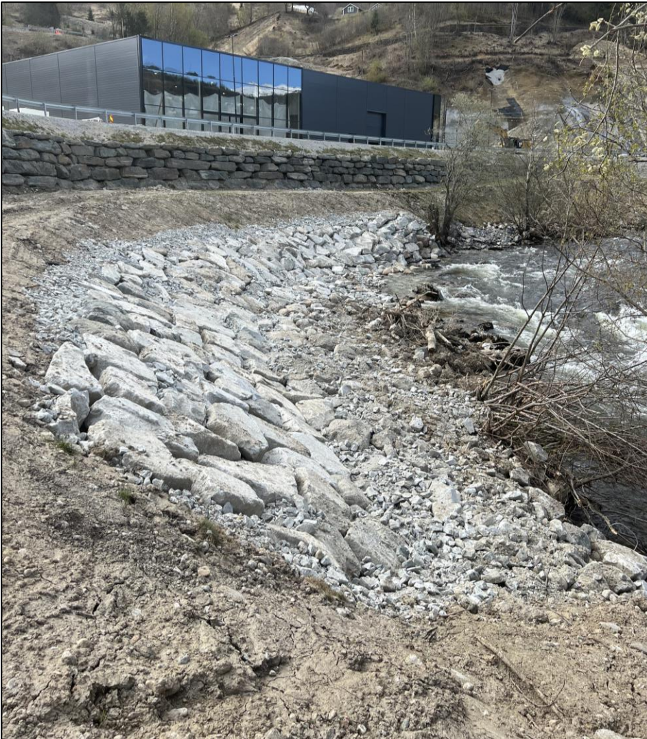
Figur 3-4: Bilde av dagens erosjonssikring.
