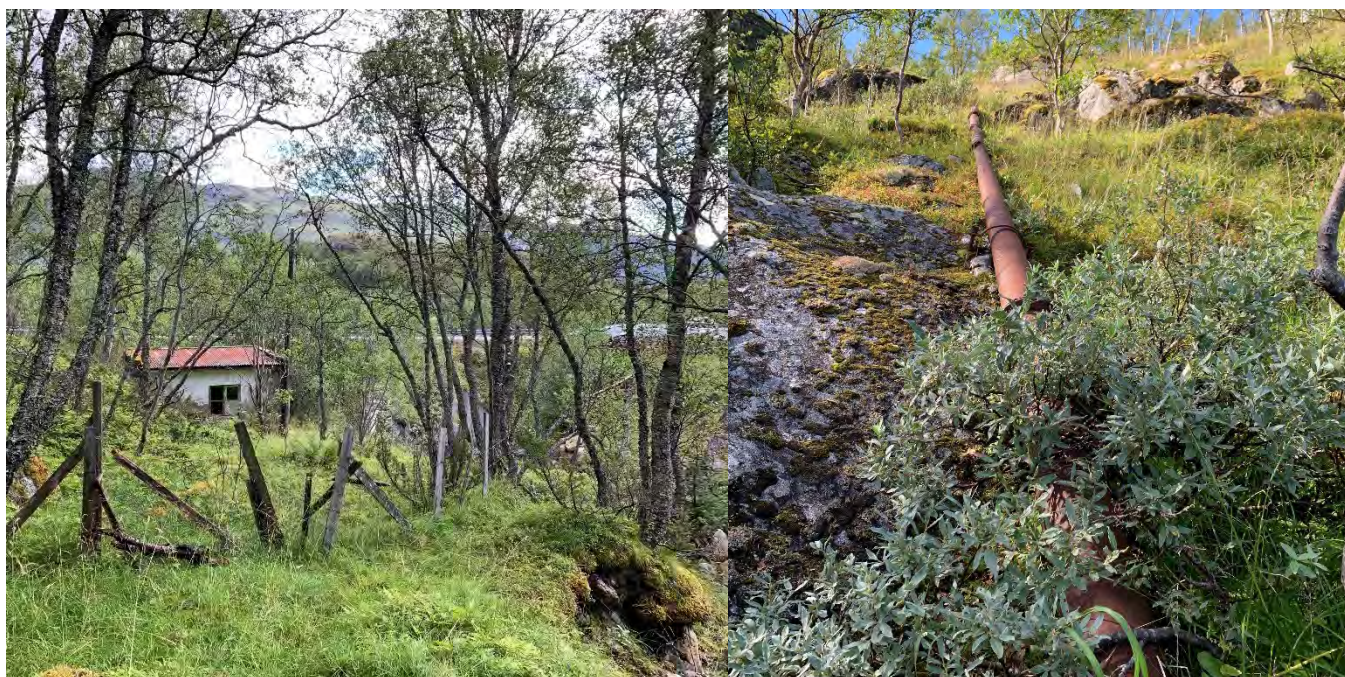
Figur 4-1 Tidligere kraftstasjon til venstre. Gammelt rør fra tidligere kraftverk til høyre.
