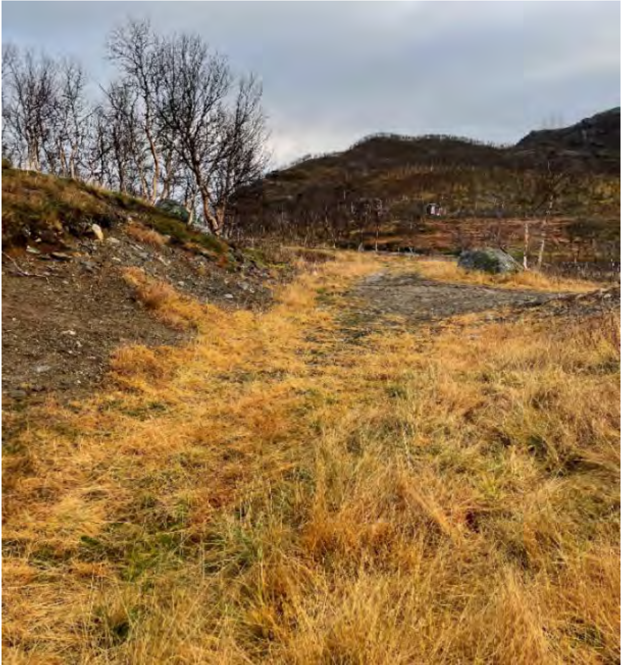
Figur 7 Øvre del av rørgatetrase/ adkomstvei fra inntak
