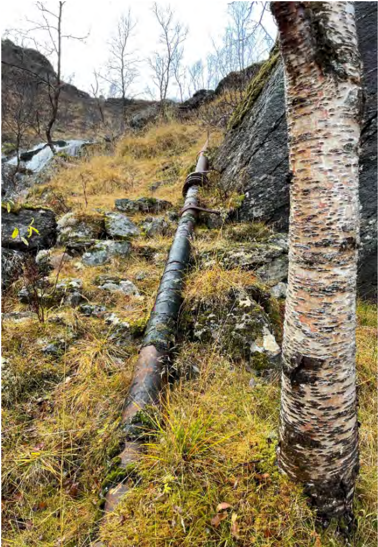
Figur 13 Rør fra det nedlagte kraftverket i det bratte partiet hvor vannvei er planlagt i borehull
