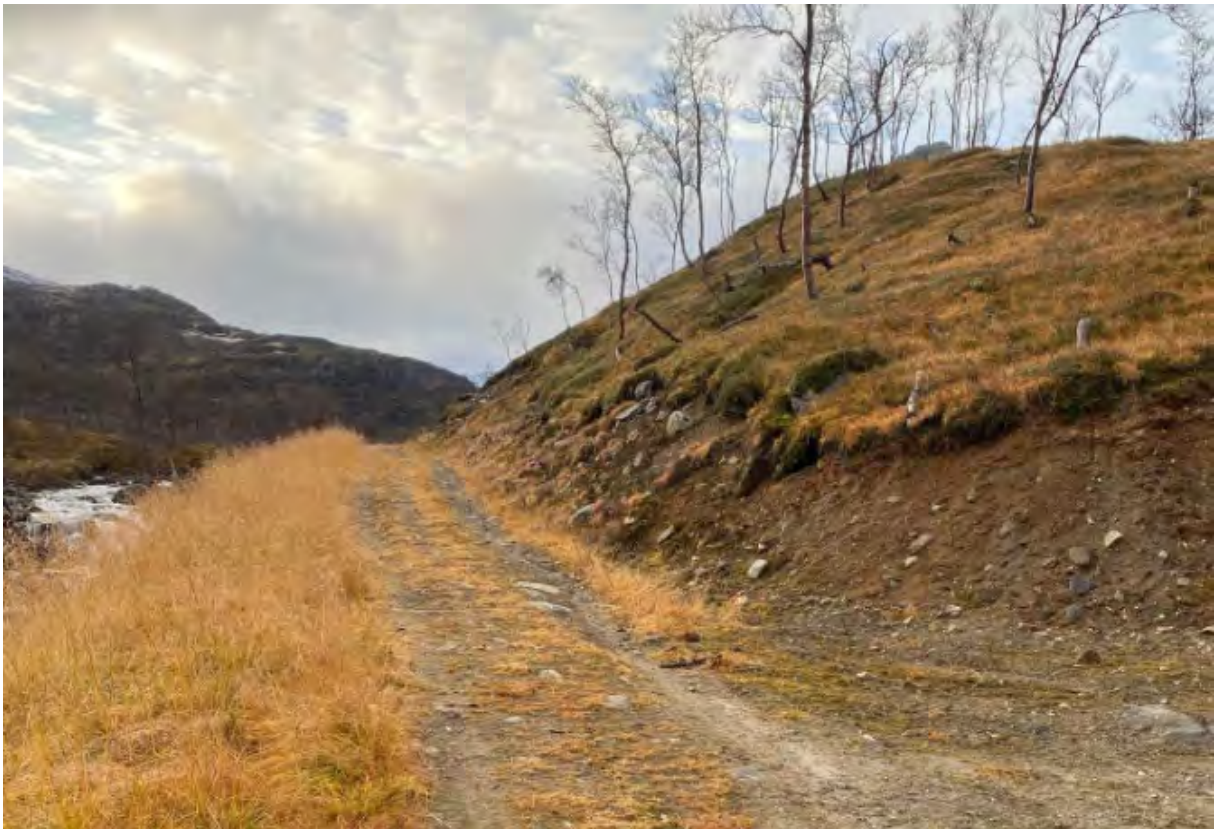
Figur 9 Øvre del av rørgatetrase/ adkomsvei
