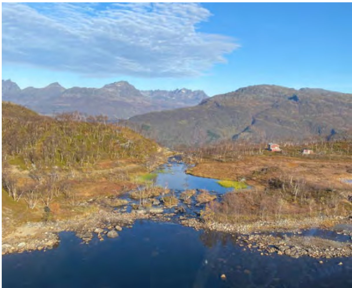
Figur 3 Flyfoto av utløpet fra Hilleshamnvannet, damplassing
