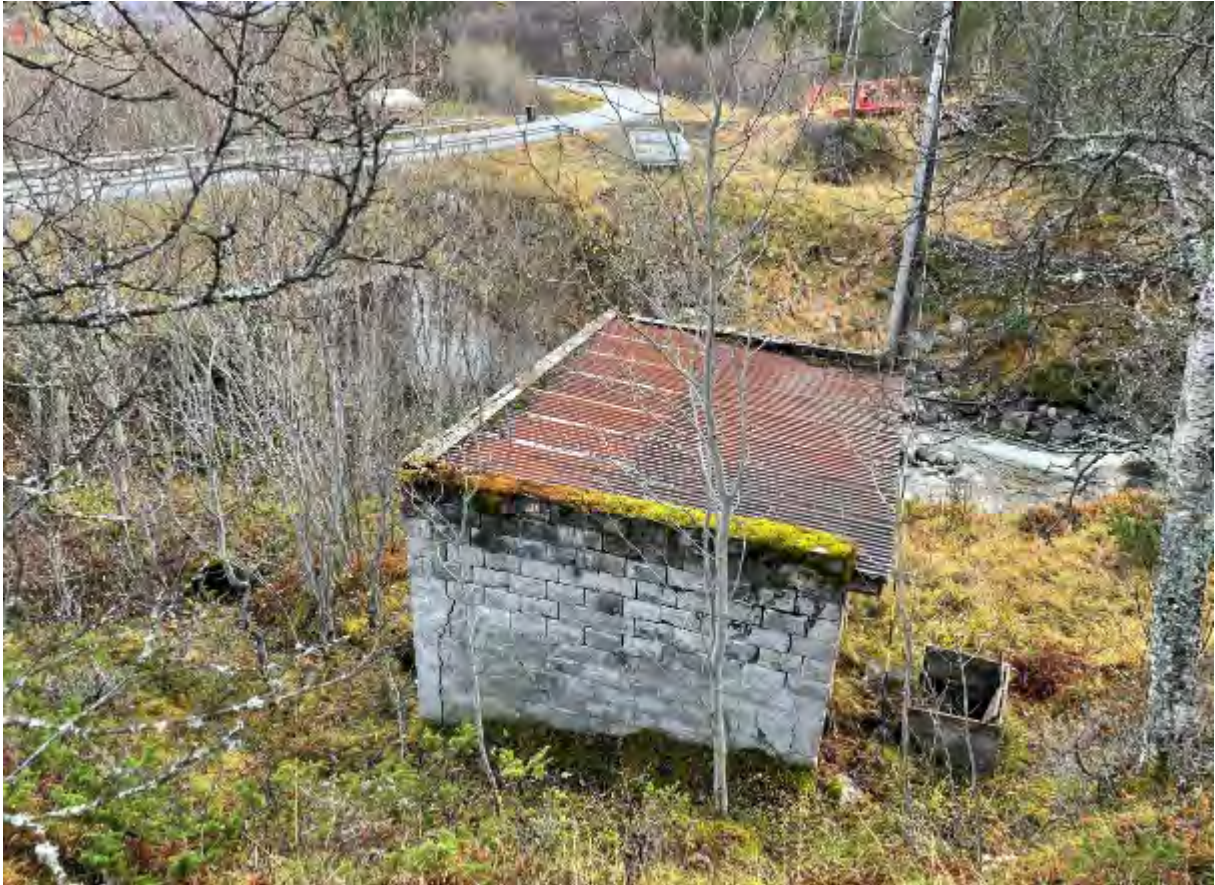
Figur 18 Kraftstasjonsplassering. Nedlagt kraftstasjonsbygning som erstattes av ny.
