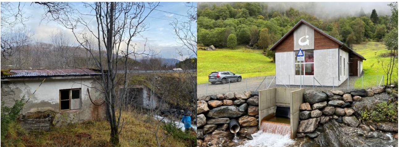
Figur 18 Nedlagt kraftstasjon i Hilleshamn, og eksempel på kraftstasjon designet av Hywer (Tverrelvi kraftverk, satt i drift i 2022)
