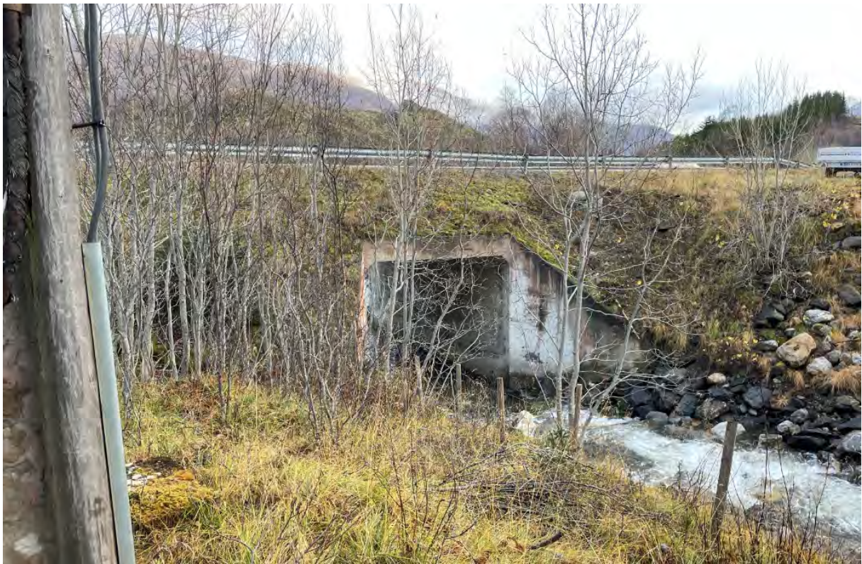
Figur 17 Kulvert under fylkesveien, bilde tatt fra nedlagt kraftstasjon
