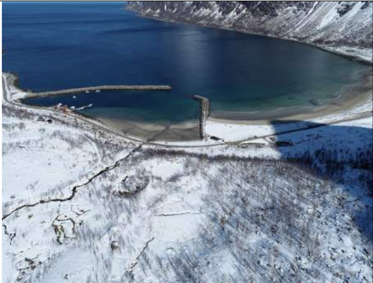
Dronefoto 4: Deler av påvirkningsområdet i terreng opp til ca. kote 40.
