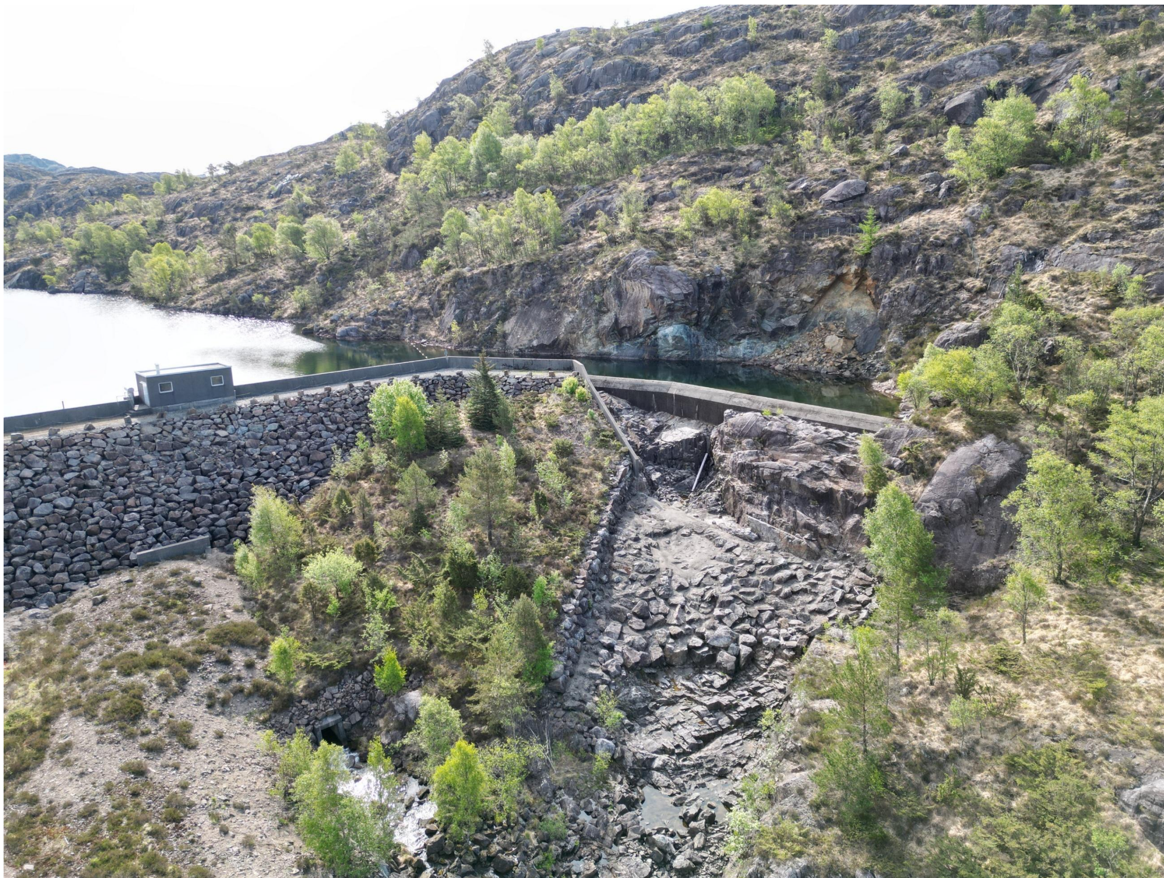
Eksisterande dam (sør): Lukehus på dam til venstre og overløp til høyre
