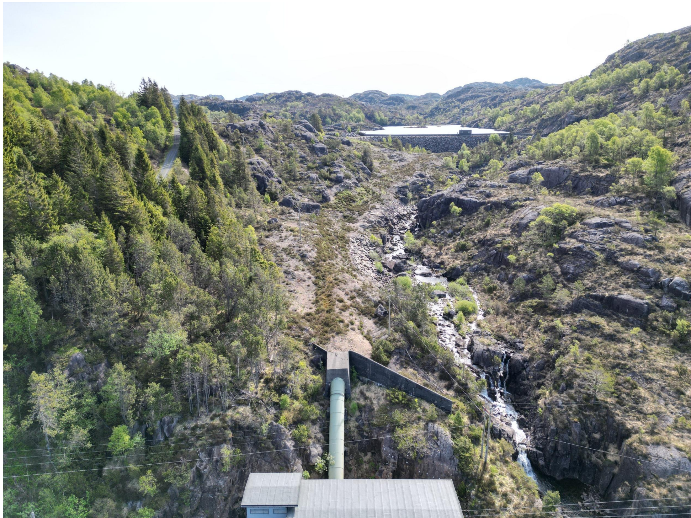
Eksisterande vassveg: Vassveg frå stasjonen opp til dam, nedst synleg stålørør og deretter nedgraven GRP.
