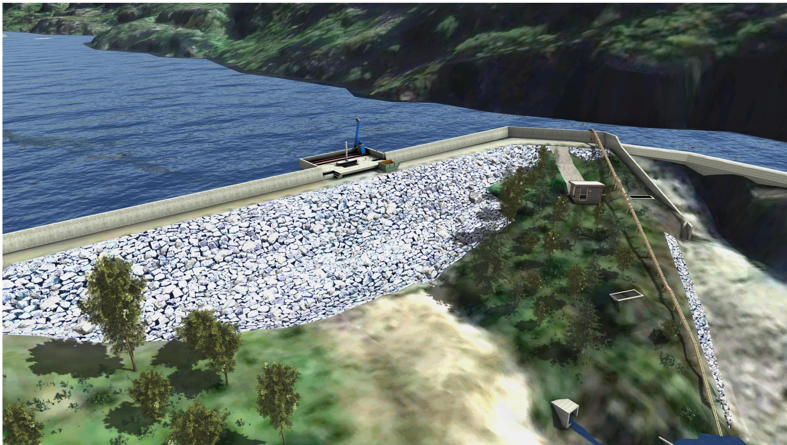
Fotoillustrasjon: Dam og inntak Honnefoss, overløp til høyre (sør) i bildet. Nytt lukehus plassert nedstrøms dam sør
