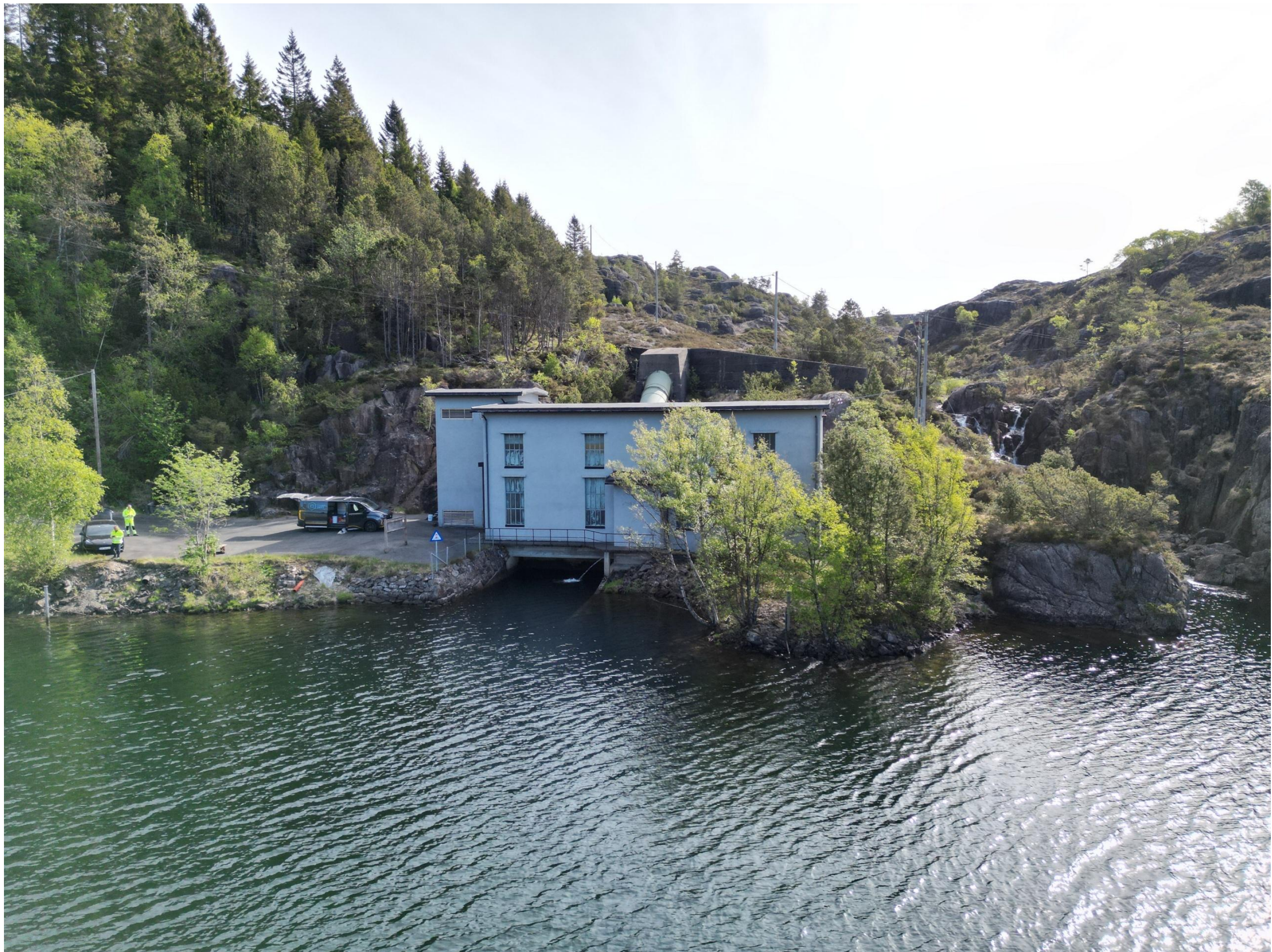
Eksisterande kraftstasjon: Kraftstasjon og synleg del av rørgate rett bak stasjonen
