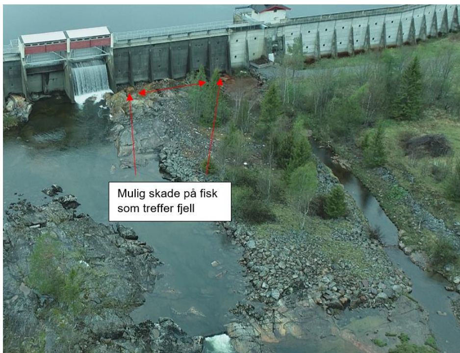
Figur 8. Også til venstre for flomlukene (sett medstrøms) vil fisk kunne falle 6-10 m rett ned på fjellet.
