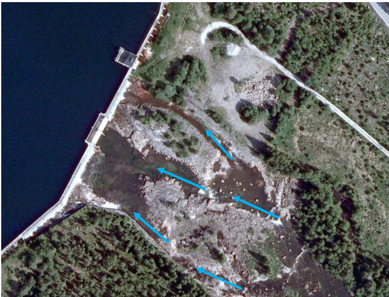
Figur 14. Sannsynlige viktigste oppvandringsrute for fisk under dammen ved lav flomvannføring (kun vannslipp ved overløpsseksjon).
