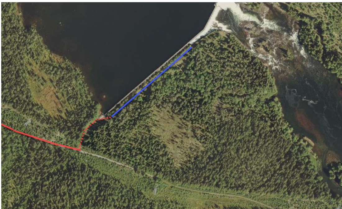
Figur 18. Adkomst via eksisterende vei. Delvis behov for opprusting og ny vei ved dammen.
