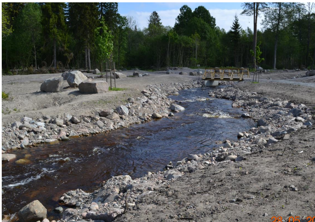
Figur 20. Eksempel på utforming av naturlikt omløp fra Storåsdammen i Sverige (Foto: Norconsult AB).
