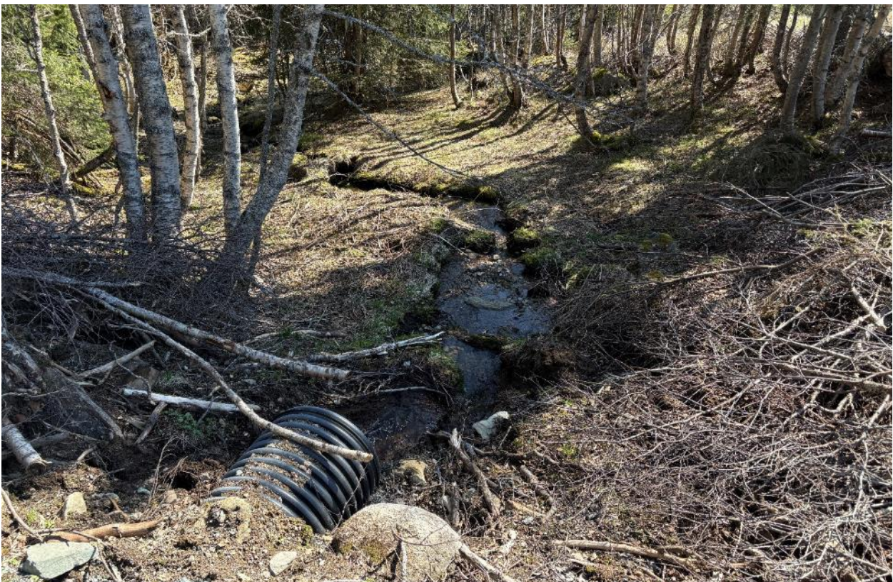
Figur 18: Infopunkt 8 i Vedlegg 4 – Registreringskart. Bekk med liten vannføring. Lite tegn til erosjon. Sett mot sørøst.
