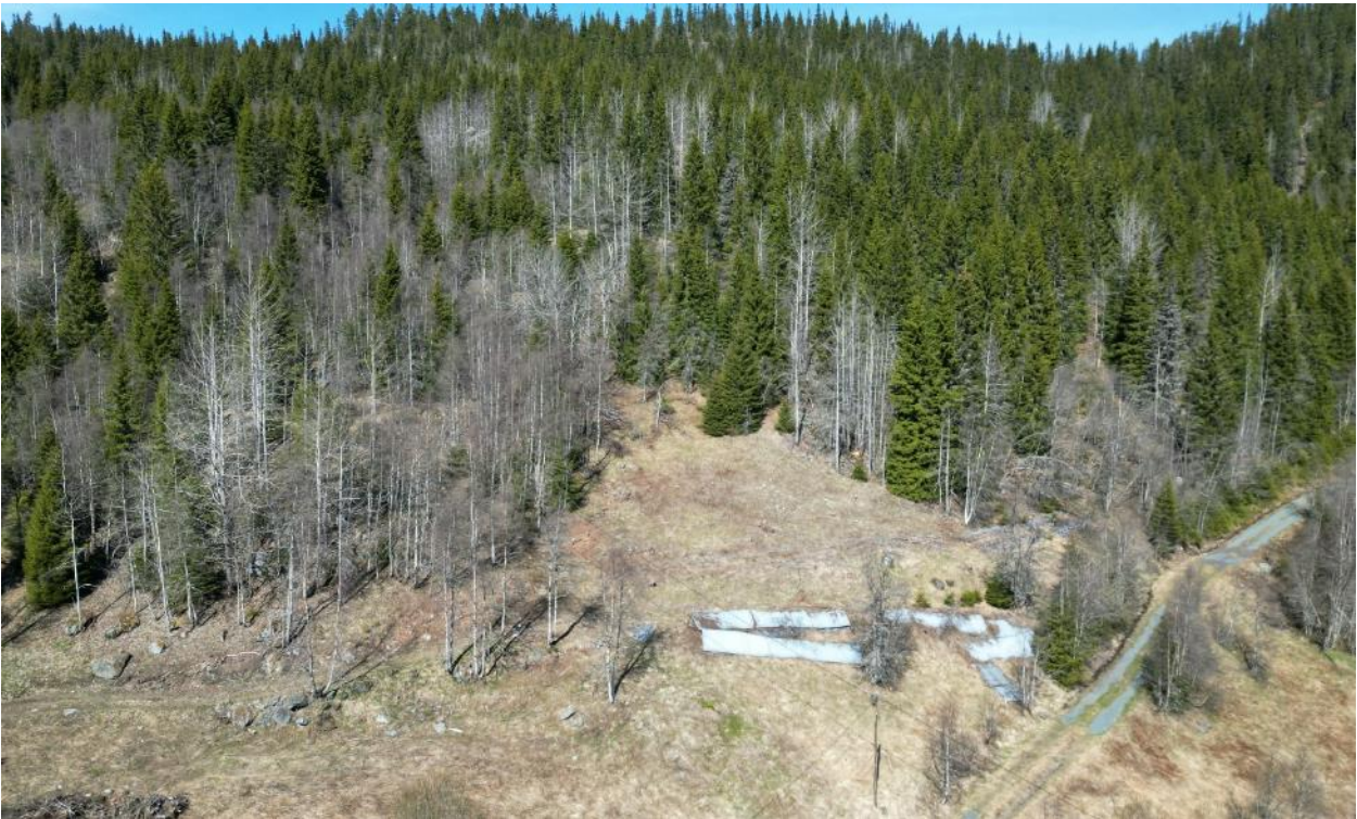
Figur 9: Oversiktsbilde av den delen av kartleggingsområdet der det planlegges nytt bolighus og garasje (der det i dag er ruiner). Sett mot nord.
