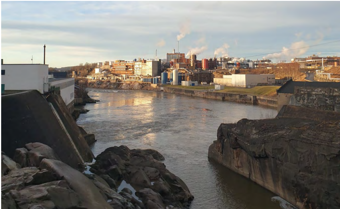
Figur 7-1 Glomma nedstrøms Sarpsfossen, med Hafslund kraftverk til venstre i bildet og Borregaard fabrikker til høyre.
