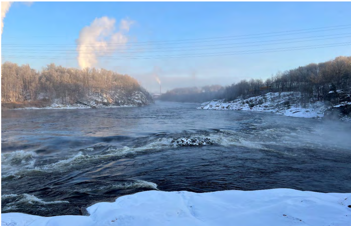
Figur 7-3 Glomma med utsikt fra utløpsområdet ved Storhaug (til høyre i bildet) opp mot Sarpsfossen
