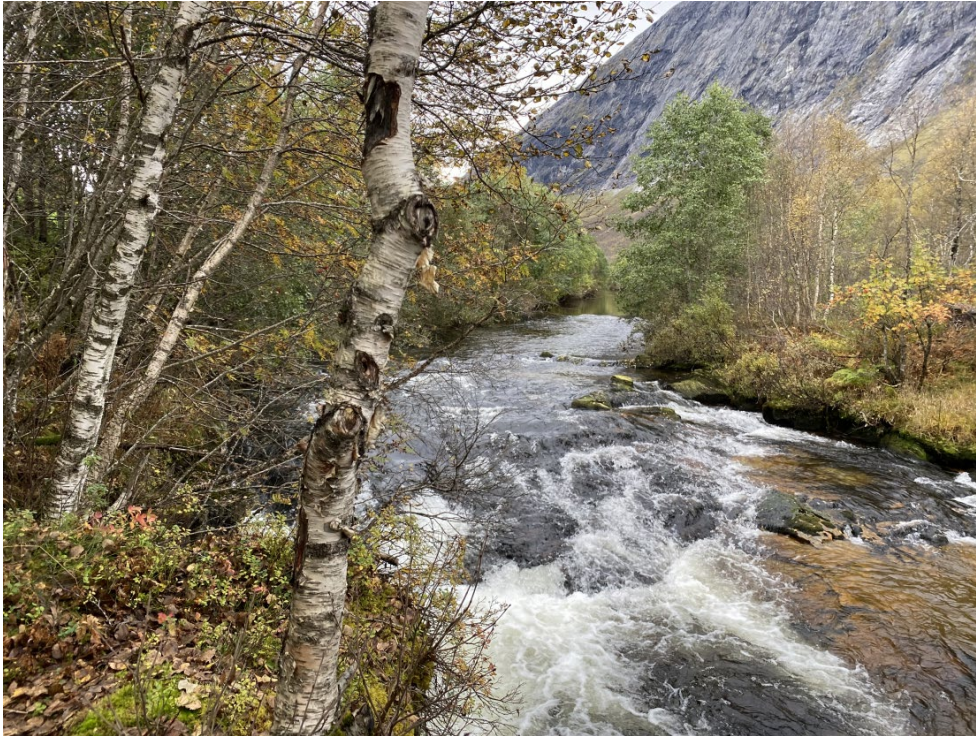
B6, Røyhus dam og inntaksområde.
