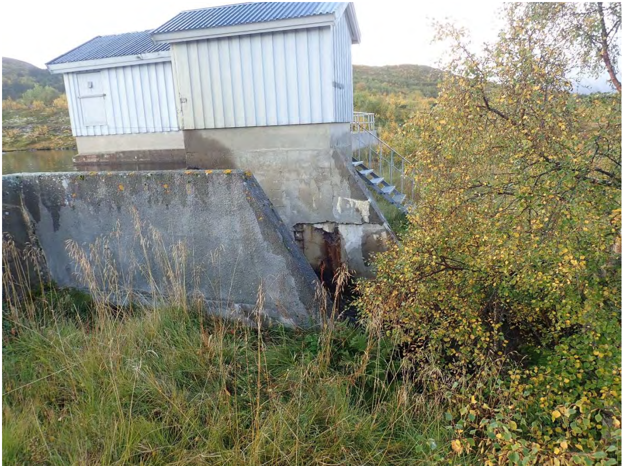
Figur 15. Overløp Nedre Leirvåg.
