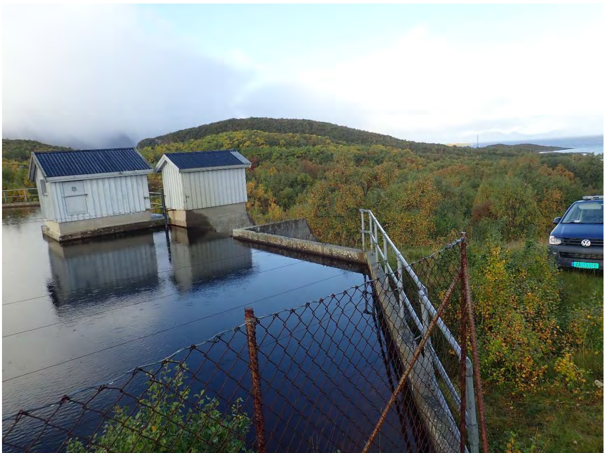
Figur 14. Ventilhus og overløp Nedre Leirvåg.
