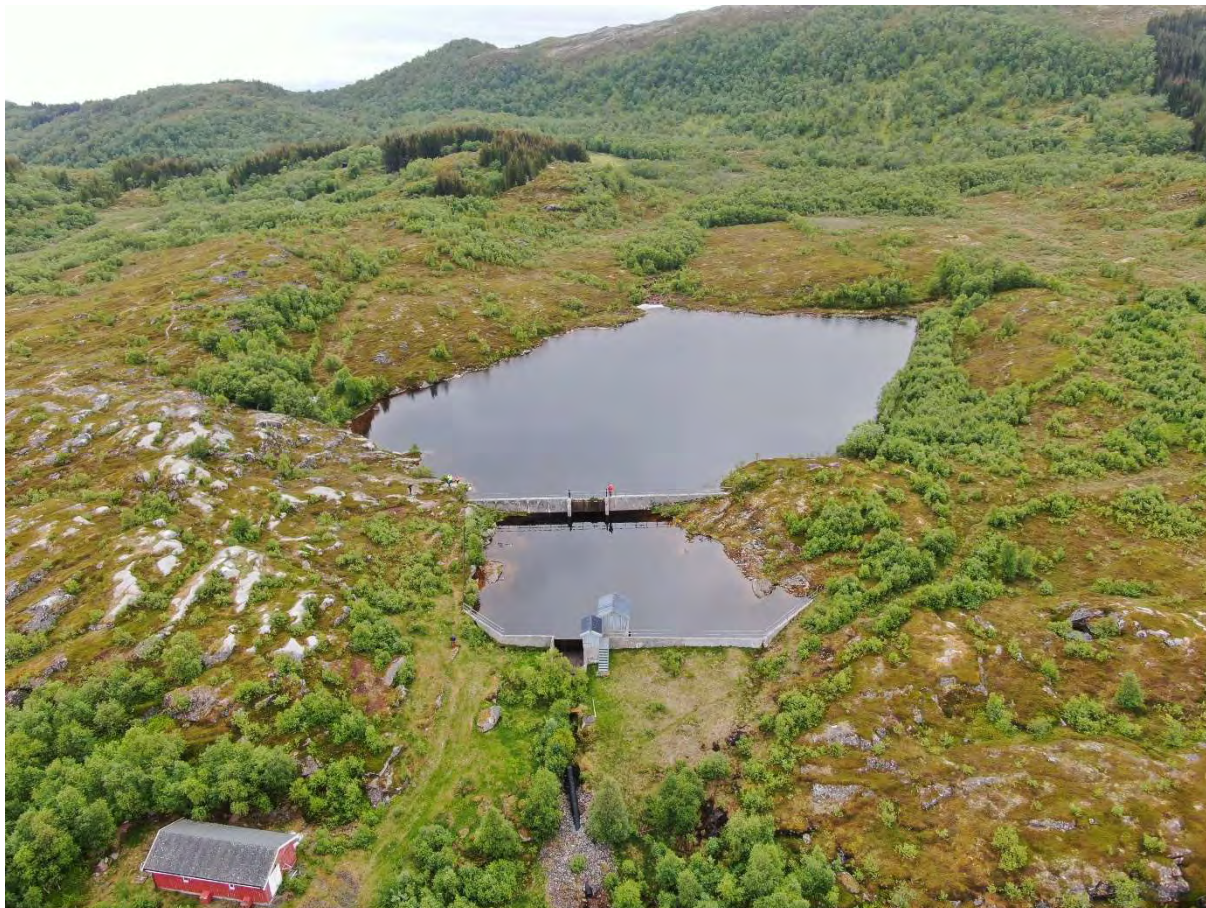
Figur 4. Dam Øvre og Nedre Leirvåg
