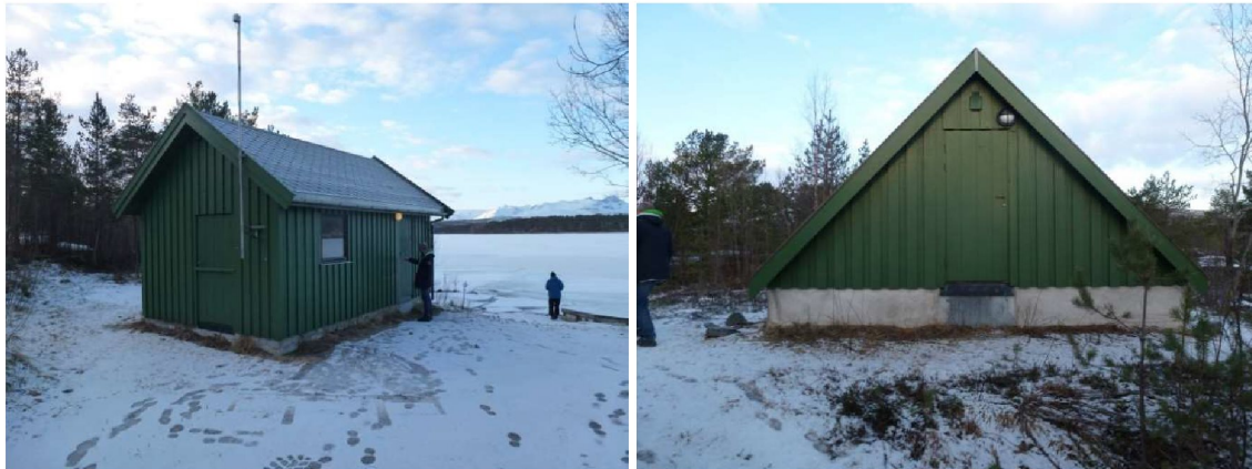
Figur 8: Pumpestasjon ved Hamnvatnet og høydebasseng ved Drag skole
