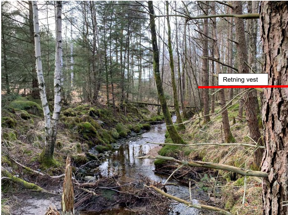
Bilde 3.9.1 Øyrabekken med flomvoll på vestsiden
