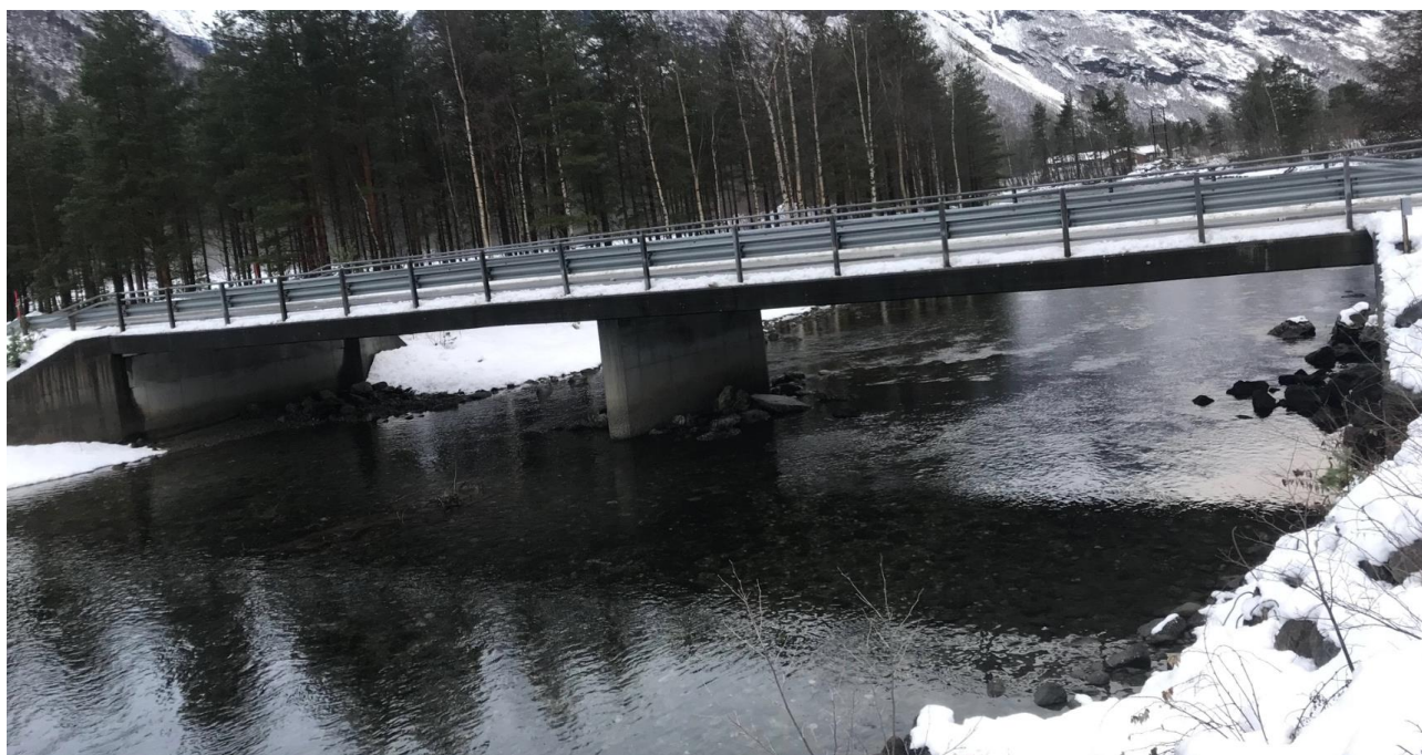
Figur 12 Vegbro som krysser Eira like oppstrøms Tyvika.
