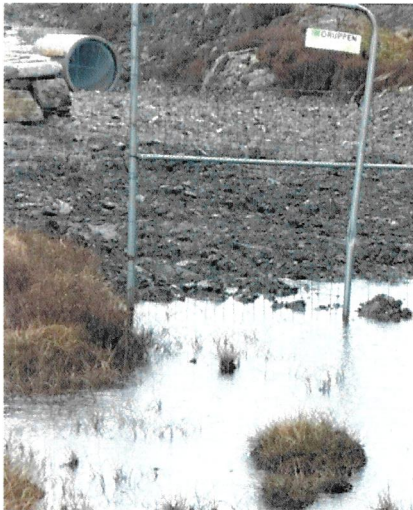
Bilde 03, Bekk og rør innløp
