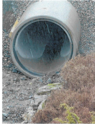
Bilde 02, Rør innløp.
