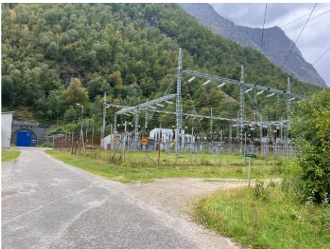
Figur 9-3 Tunnellinngang til kraftverk (Guolásjohka) og trafostasjon langs elva
