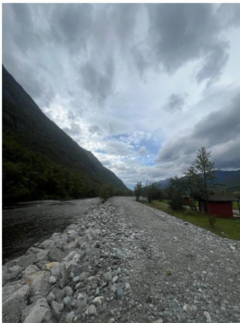
Figur 9-8 Ny flomvoll/forvygning langs camping i nærheten av utløpet til sjø.
