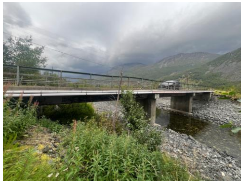
Figur 9-4 Bru over til kraftverk og trafostasjon
