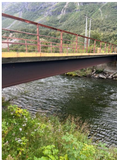
Figur 9-6 Holmen bru. Bildet tatt fra VM 206.2 Homen bru målestasjon
