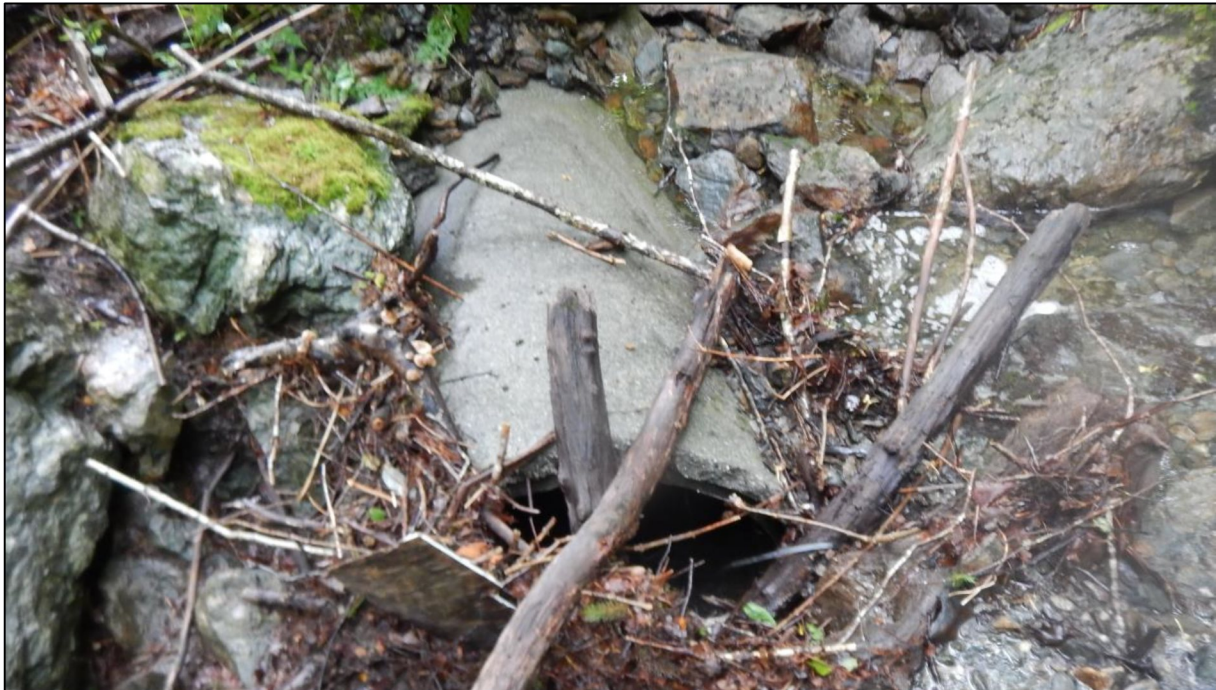
Figur 10: Bilde av kulvertinntaket ved punkt 1.
