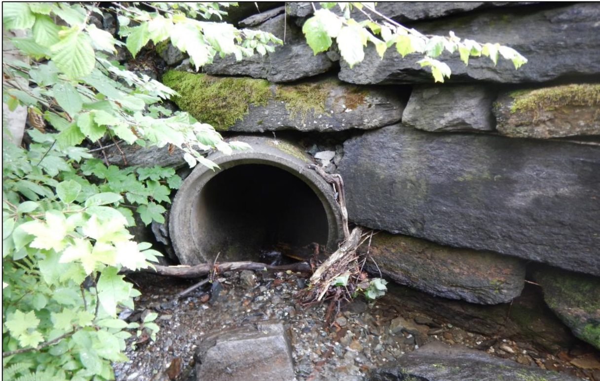
Figur 12: Bilde av kultvertinntak ved punkt 4.
