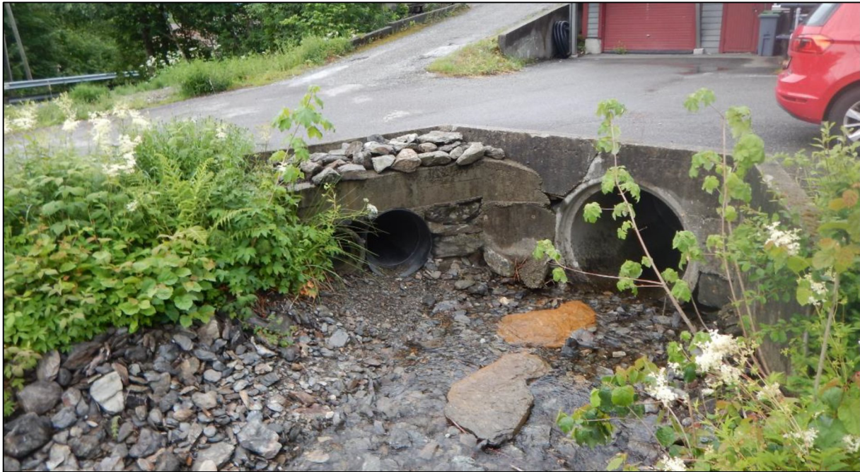
Figur 11: Bilde av kulvertinntak ved punkt 3.
