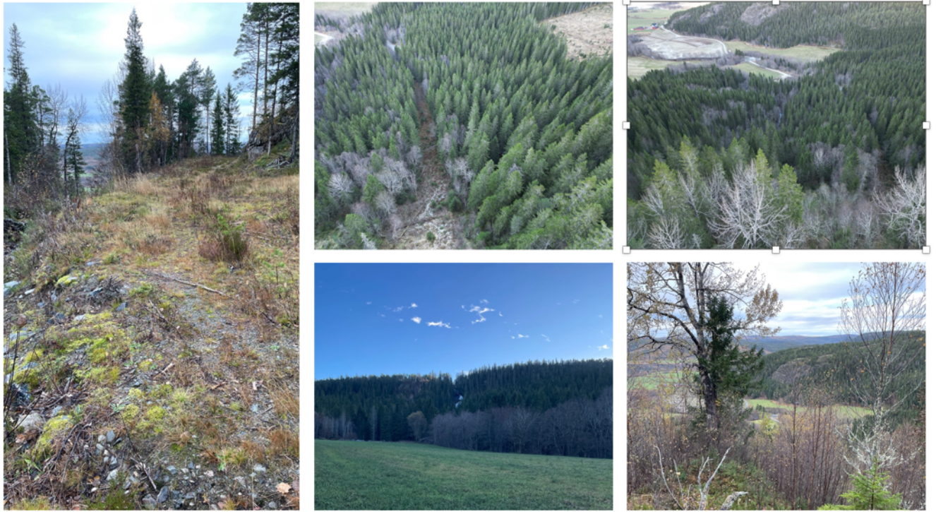
Figur 2-9 Bilder som viser rørgata slik den ser ut i dag. Rørgata er i praksis ikke synlig fra dalen.
