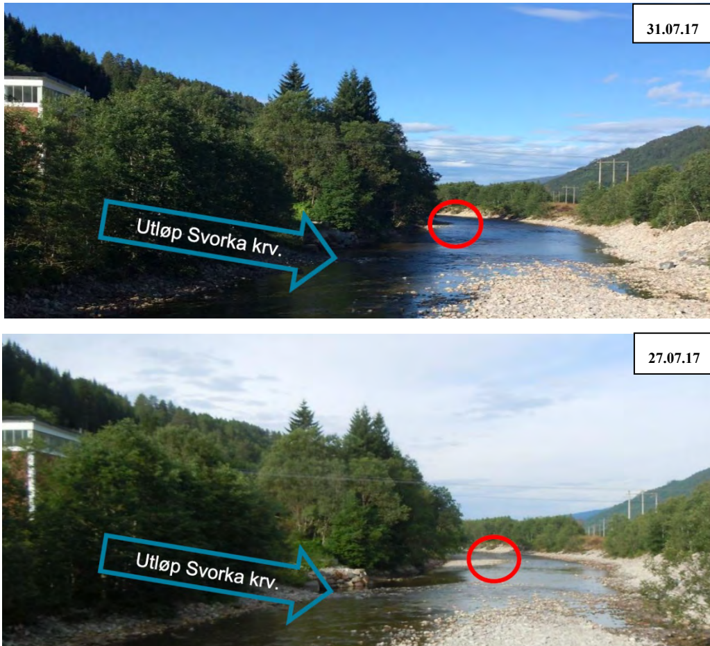
Figur 14: Bilder nedstrøms utløpet av Svorka kraftverk. På det nedre bildet er vannføringen ca. 0,47 \text{ m}^3/\text{s} , og det er ingen vannføring gjennom Svorka kraftverk. På øvre bildet er vannføringen ca. 3,7 \text{ m}^3/\text{s} , vannføringen gjennom Svorka kraftverk er ca. 3,1 \text{ m}^3/\text{s} .
