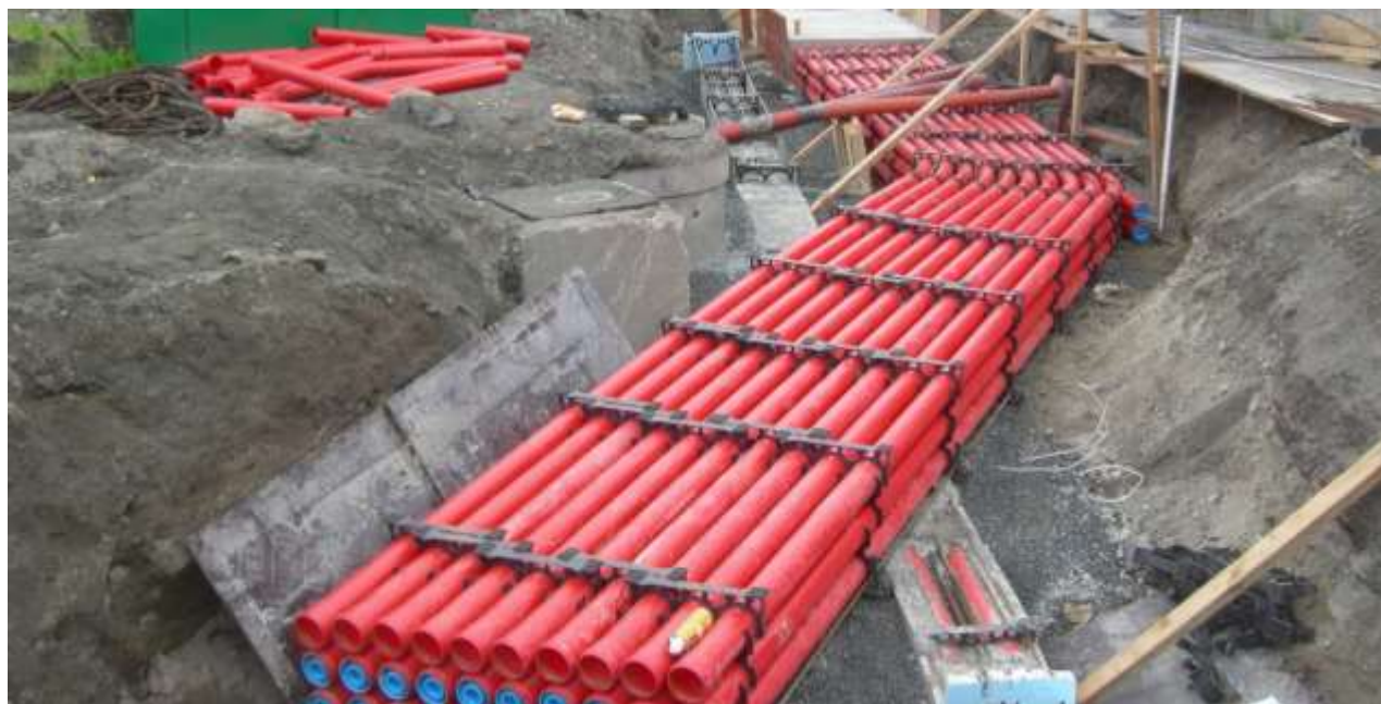
Figur 2-3 Eksempel på en OPI-kanal (Equinor vil kun ha et eller to rør, men prinsippet er det samme). Med unntak av kortere strekninger på 20-30 meter for hver 800 meter pga. «kabelstrekker», vil grøften reetableres fortløpende og maks innen en uke. Kabelen trekkes helt til slutt.
