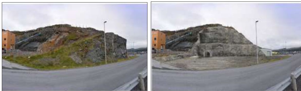
Figur 2-4 Overgang fra kabel i tunell (stiplet linje) til sjøkabel (heltrukken linje) ved Meland. Planlagt skjæring 30 meter lagt i terrasser i fjellknausen. Stigen er vist som brunt område til høyre for Rossmollgata) Fotomontasje: terrenget før og etter ved tunellpåhugget i fjellknausen Stigen. Kilde: Multiconsult 2020/Equinor.
