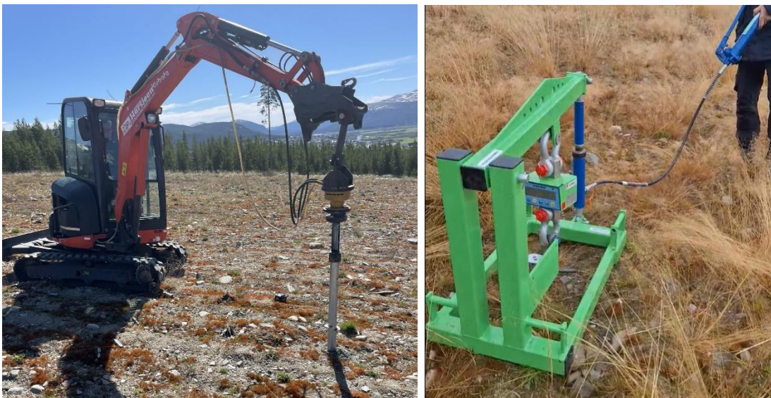
Figur 4-4. Det ble utført prøvfundamentering med jordskruer i mai 2024 (t.v.) og uttrekkstest i oktober 2024 (t.h.). Bilde: Krapter AS
