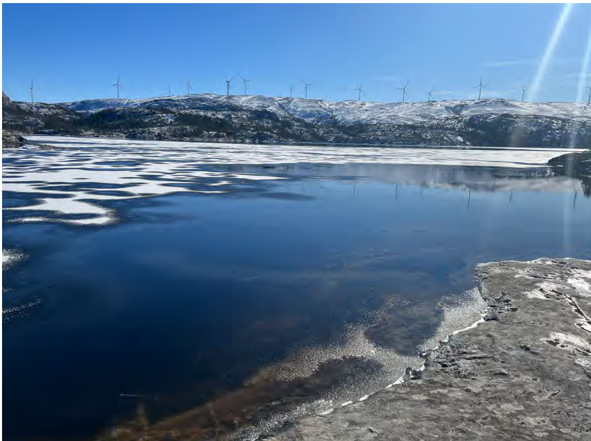
Grovlivannet sett fra dam Grovlivann
