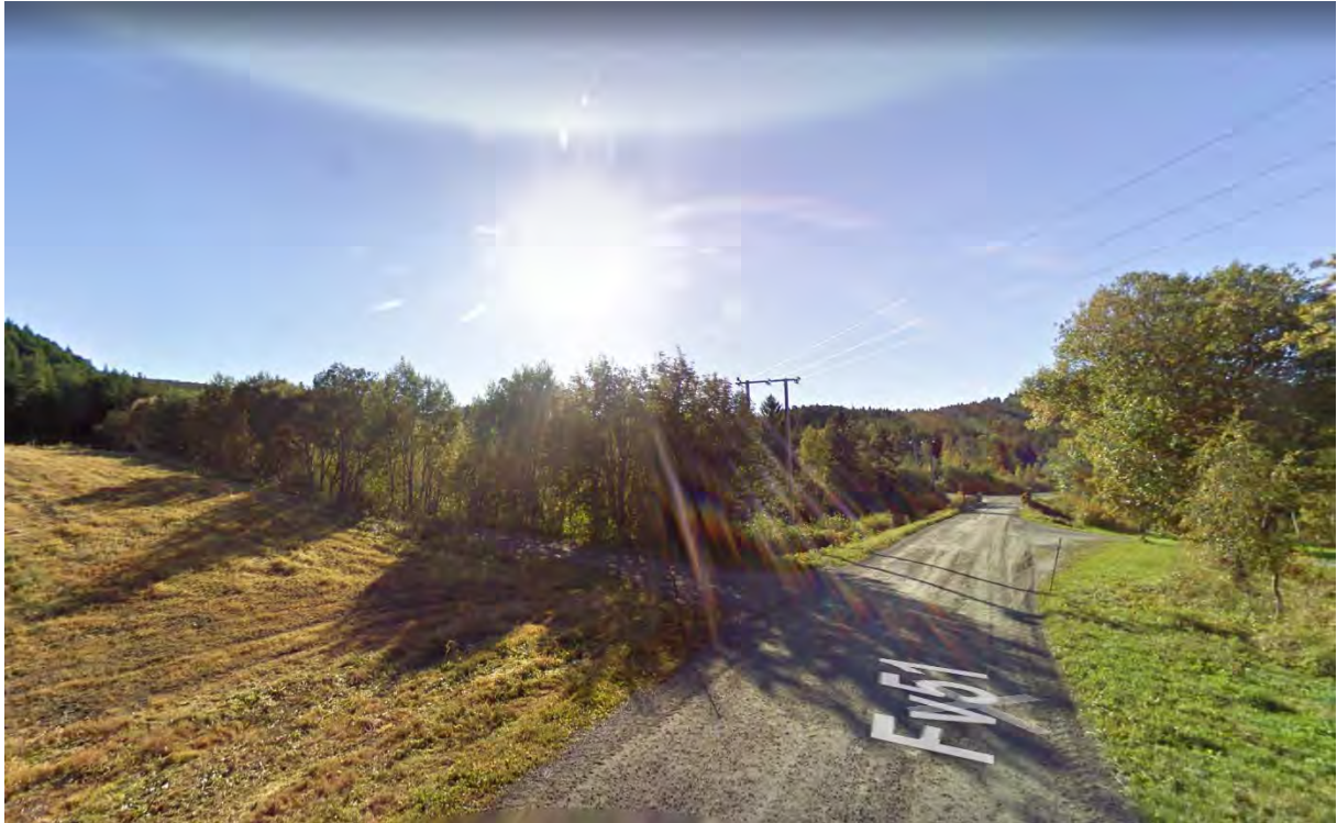
Avkjøring mot kraftverket fra fylkesvei. Tilknytningspunkt mot eksisterende 22 kV nett.
