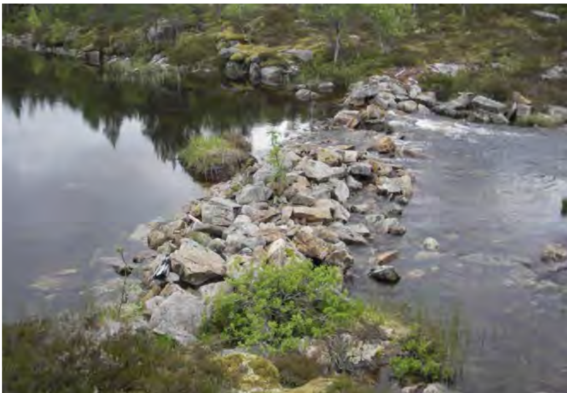
Rester av steinfyllingsdam oppstrøms planlagt inntak i Grovlielva
