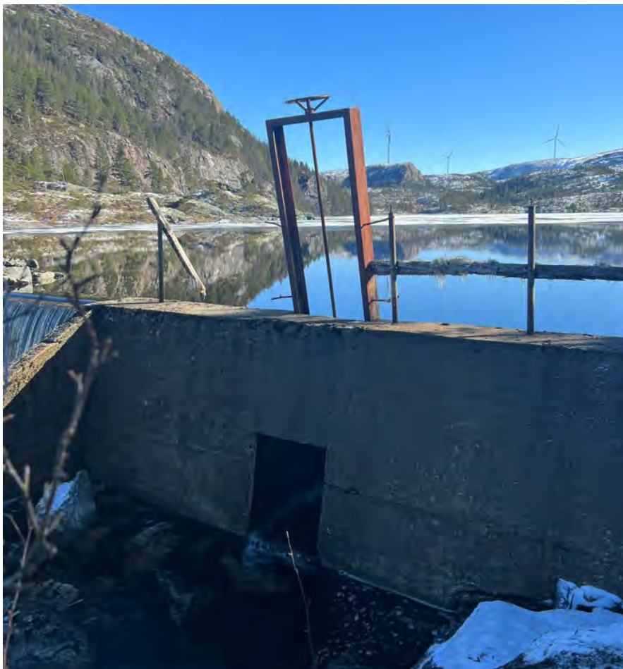
Eksisterende dam med luke
