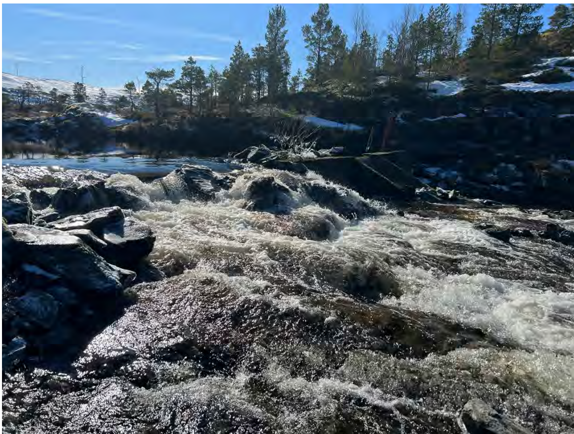
Eksisterende reguleringsdam ved Grovlivannet med overløp
