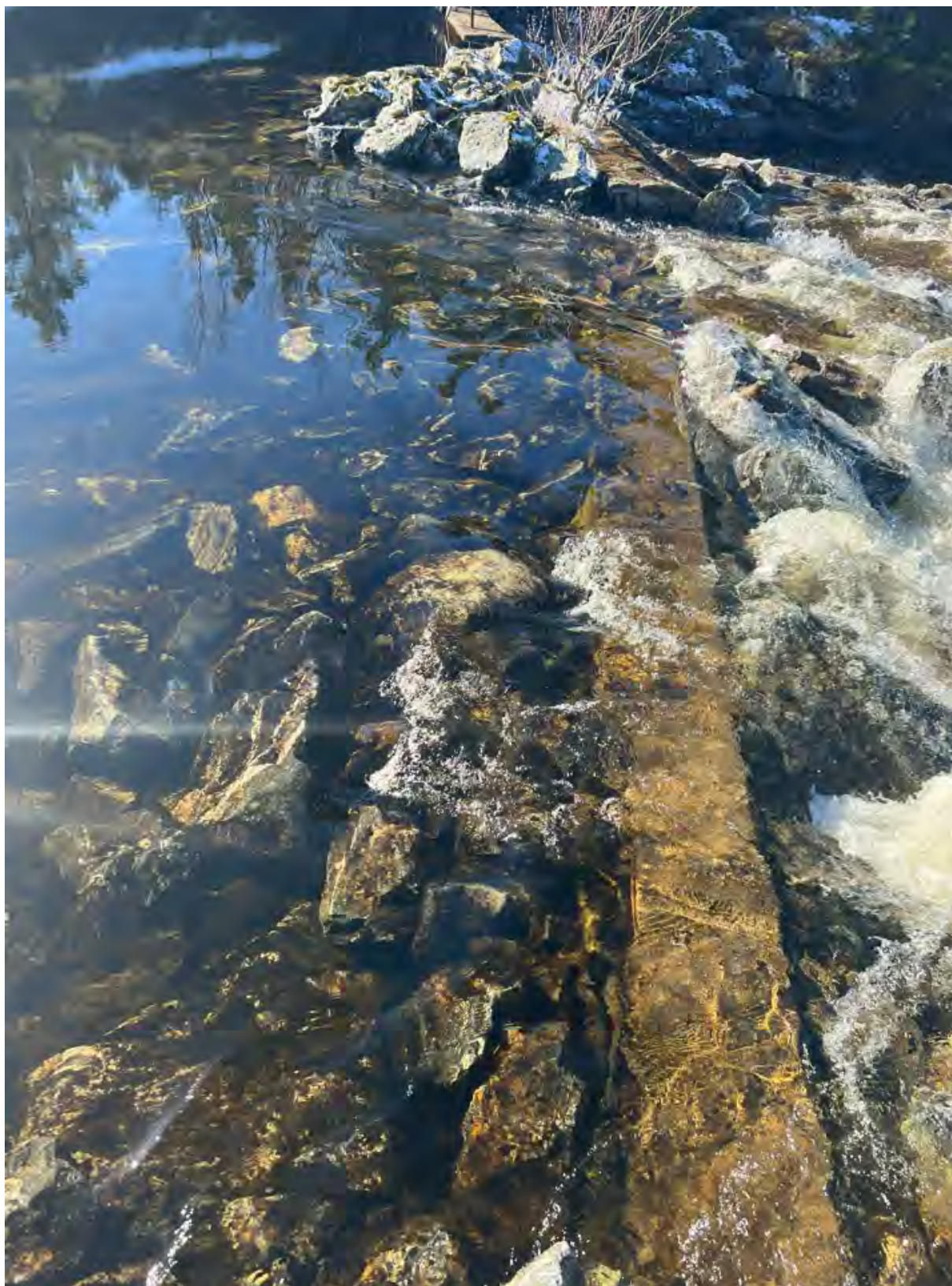
Overløpsterskel dam Grovlivann
