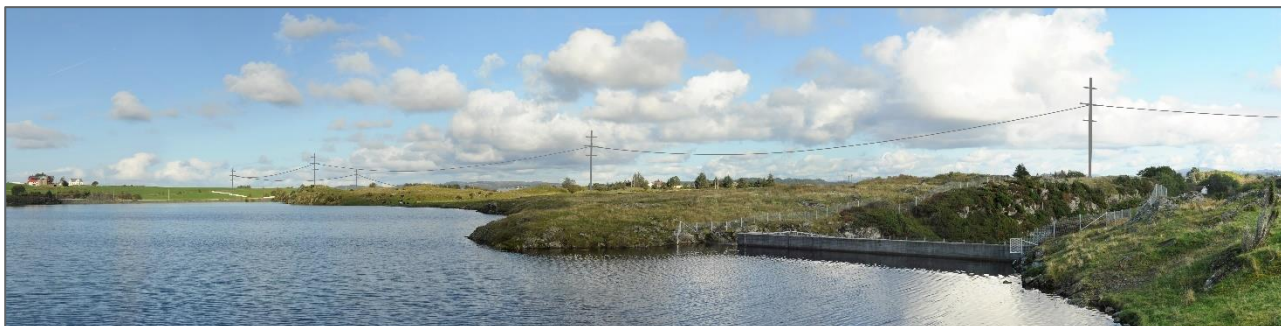
Figur 2-21. Streksskisse av ny situasjon med alternativ 1b forbi Fiskåvatnet. Dagens 66 kV-ledning er synlig i bildet, men denne skal rives som en del av tiltaket.
