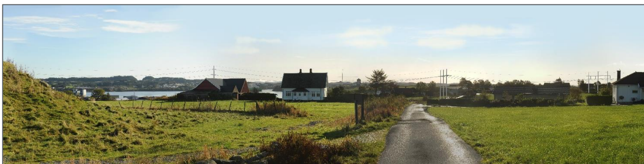
Figur 1-9: Visualisering av ny trasé (alternativ 1d) med planopphegmast forbi Rehaugane. Kabling av lavspentnettet er også vist i visualiseringen.
