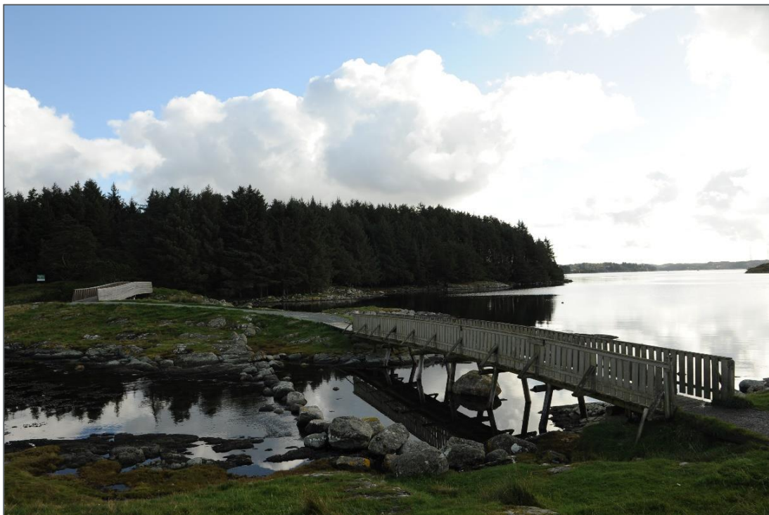
Figur 2-56: God tilrettelegging med broer over til Bukkøy.
