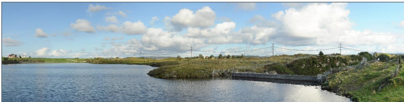
Figur 2-26. Strekskisse av ny situasjon med alternativ 1c forbi Fiskåvatnet. Dagens 66 kV-ledning er synlig i bildet, men denne skal rives som en del av tiltaket.
