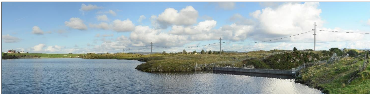
Figur 2-18. Strekskisse av ny situasjon med alternativ 1 forbi Fiskåvatnet. Damanlegget er synlig til høyre. Eksisterende 66 kV-ledning er synlig i bildet, men denne skal rives som en del av tiltaket.
