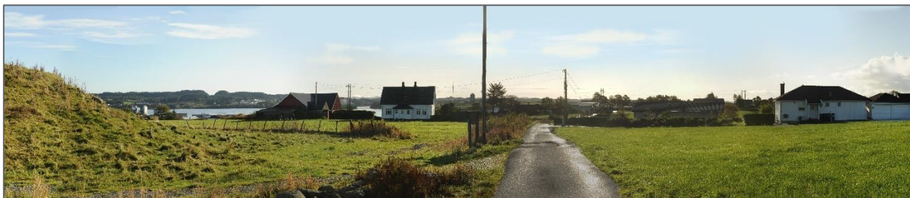
Figur 2-51 Dagens situasjon ved Rehaugane. Lavspenstledninger og lyktestolpe er synlig langs veien.
