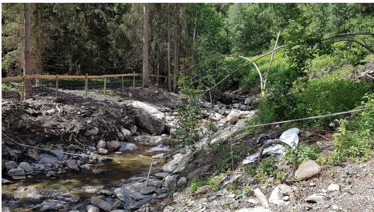
Bilde 37: Krysning av traktorveg nedenfor Torgerhaugen, sett oppstrøms.
