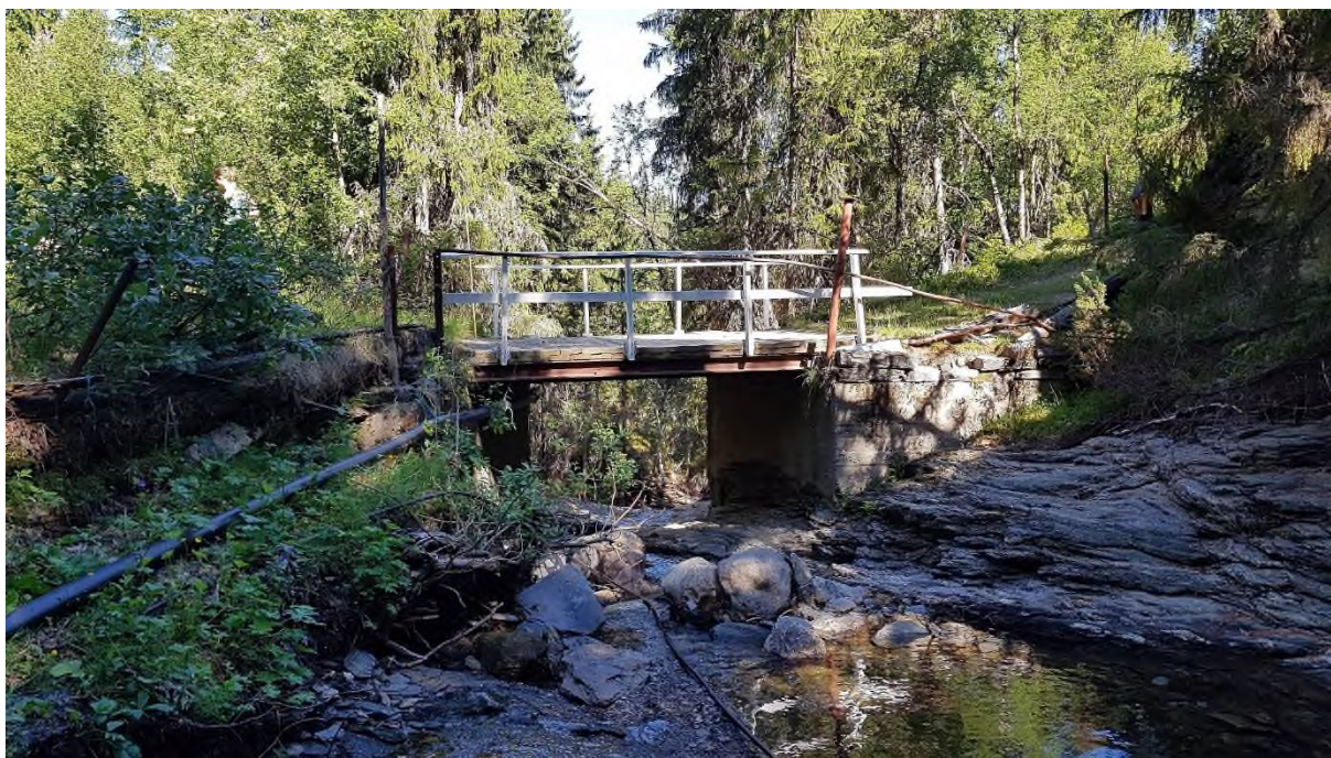
Bilde 19: Vegkrysning Baukholstulvegen 158, sett fra oppstrøms side
