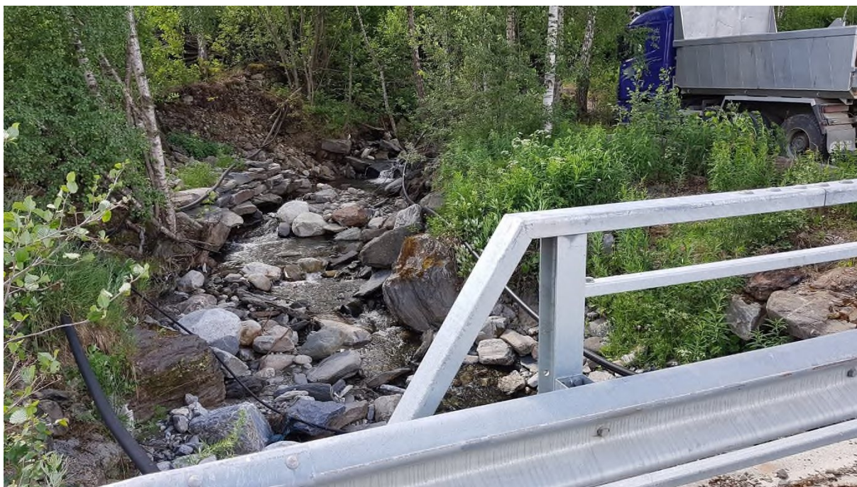
Bilde 46: Oppstrøms kulvert Gammelskulevegen
