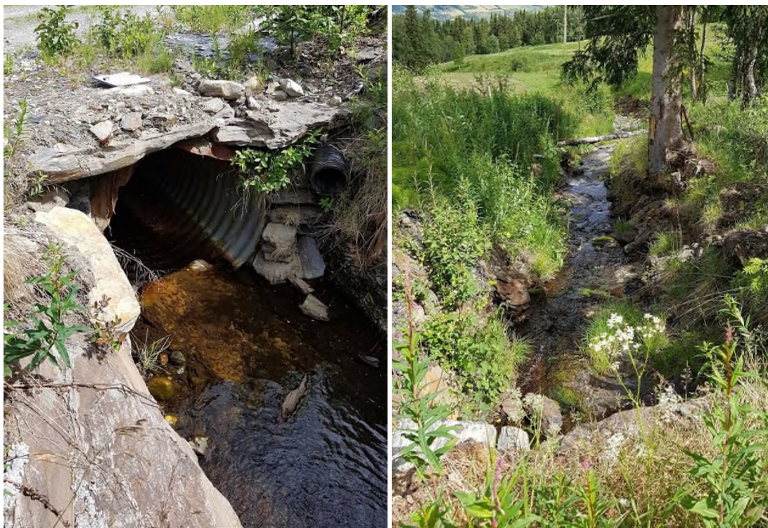
Bilde 90: Vegkrysningen inn til Dalsbaukhol, innløp til venstre, nedstrøms utløp til høyre
