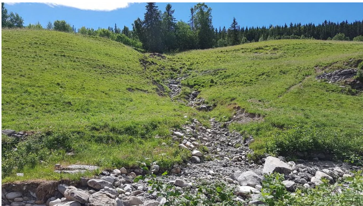
Bilde 42: Viser erosjon på jorde rett oppstrøms Gammelskulevegen
