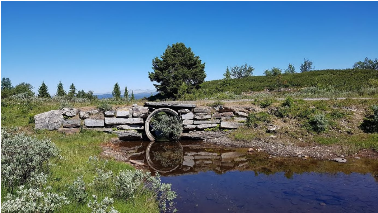
Bilde 9: Innløp vegkrysning Grønsletta
