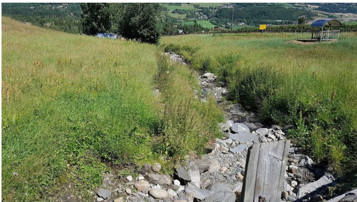
Bilde 83: Utløp vegkrysning gårdsveg oppstrøms Baksidevegen
