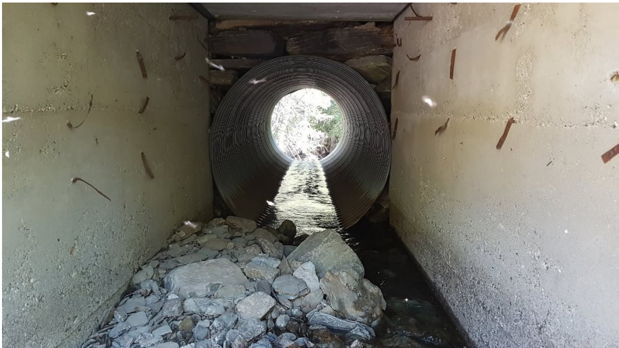
Bilde 15: Dimensjonsendring av kulvert i vegkrysning Baukholstulvegen
