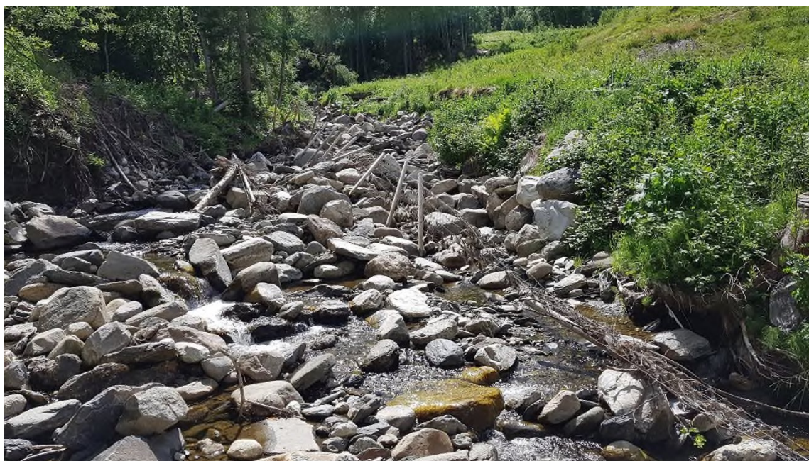
Bilde 26: Nedstrøms bekkekrysset Skurdalså/bekk fra Enge, har erosjon ført til at elva har revet med seg et gjerde.
