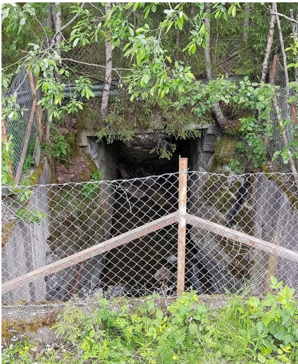
Bilde 22: Utløp kulvert under gammel veg og innløp vegkrysning Gålåvegen
