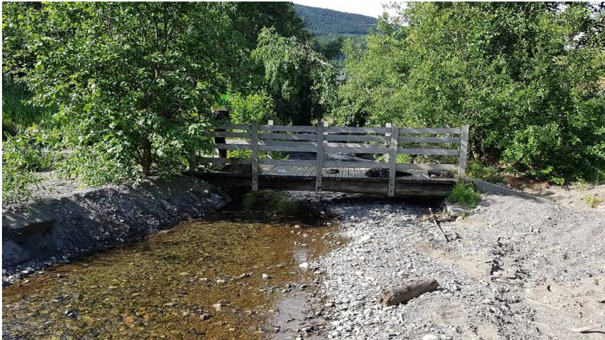
Bilde 77: Gangbru utløp Skurdalsåa
