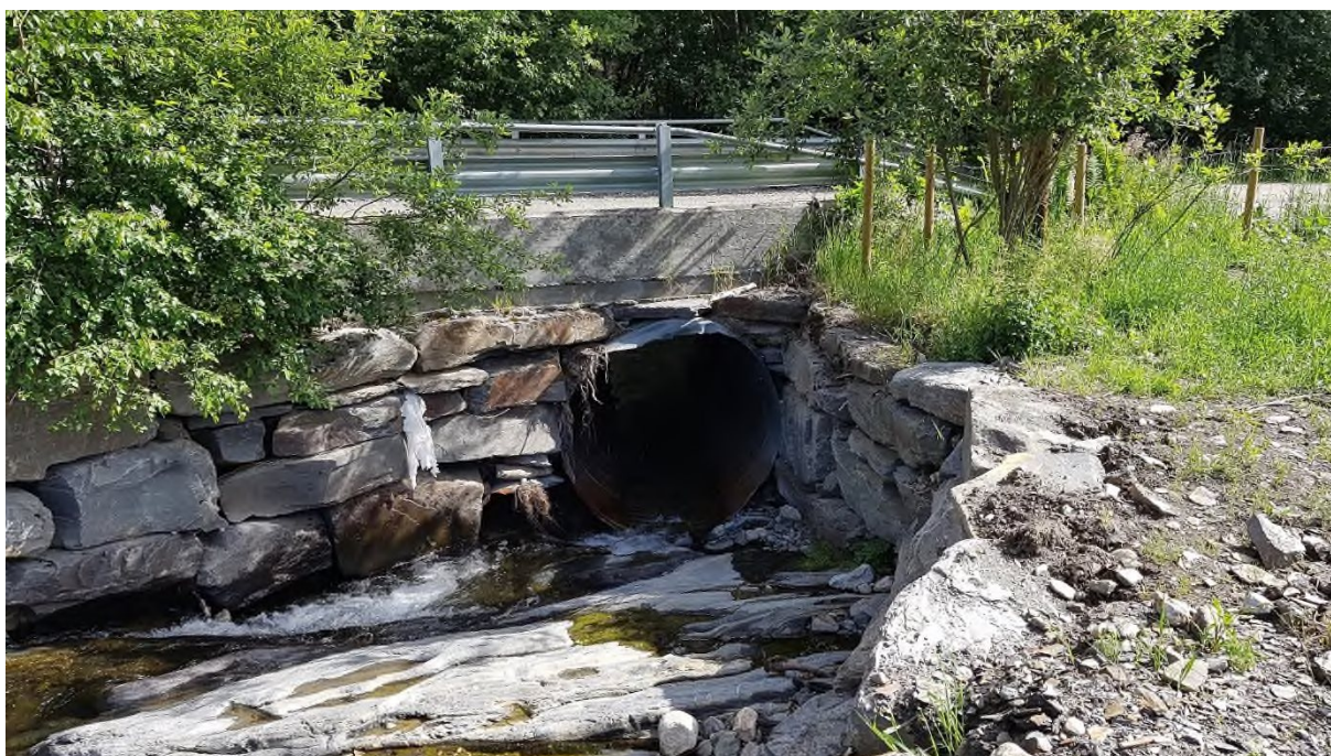
Bilde 62: Innløp vegkrysning Vintervegen
