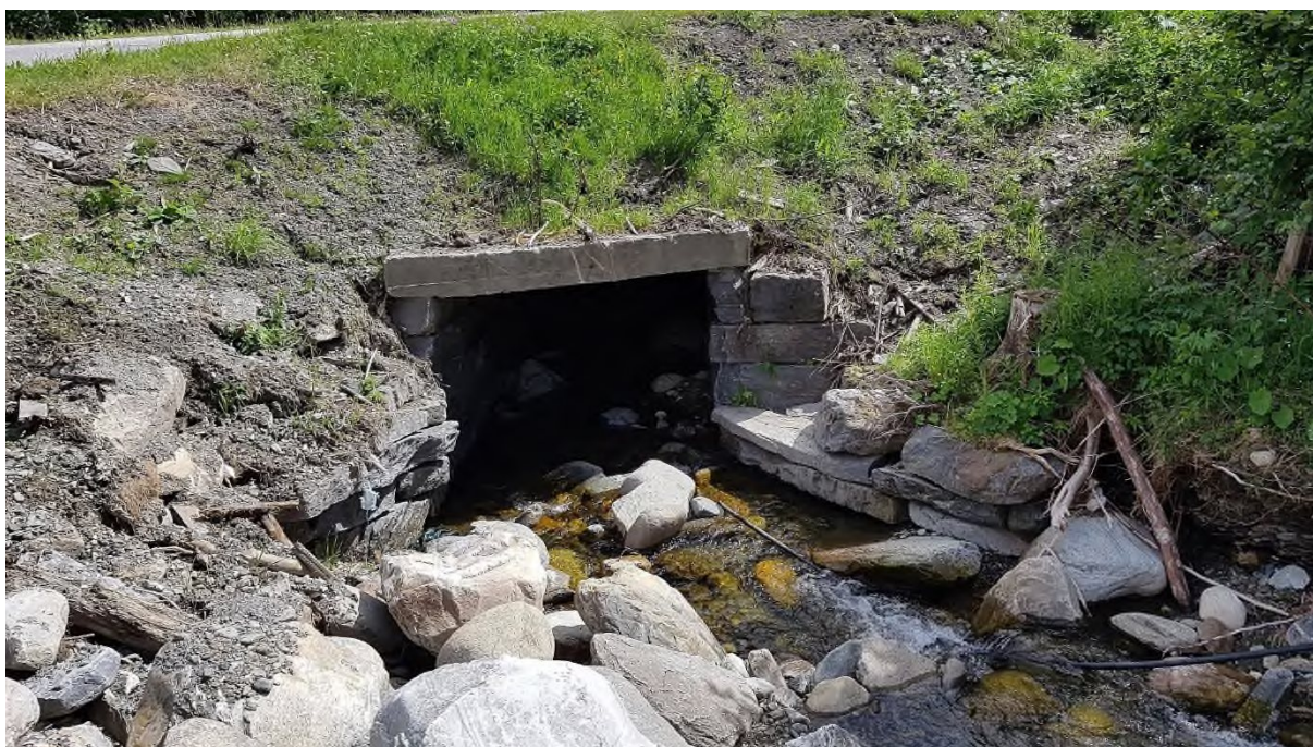
Bilde 27: Innløp vegkrysning Dålåstigen 467
