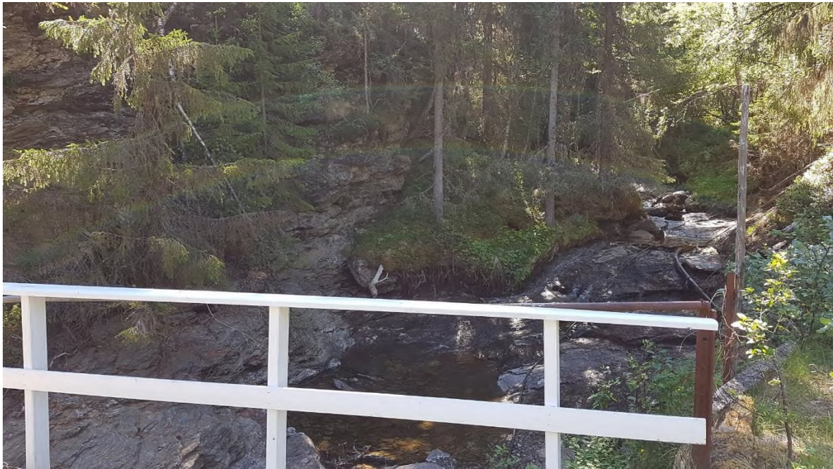
Bilde 20: Oppstrøms vegkrysning Baukholstulvegen 158
