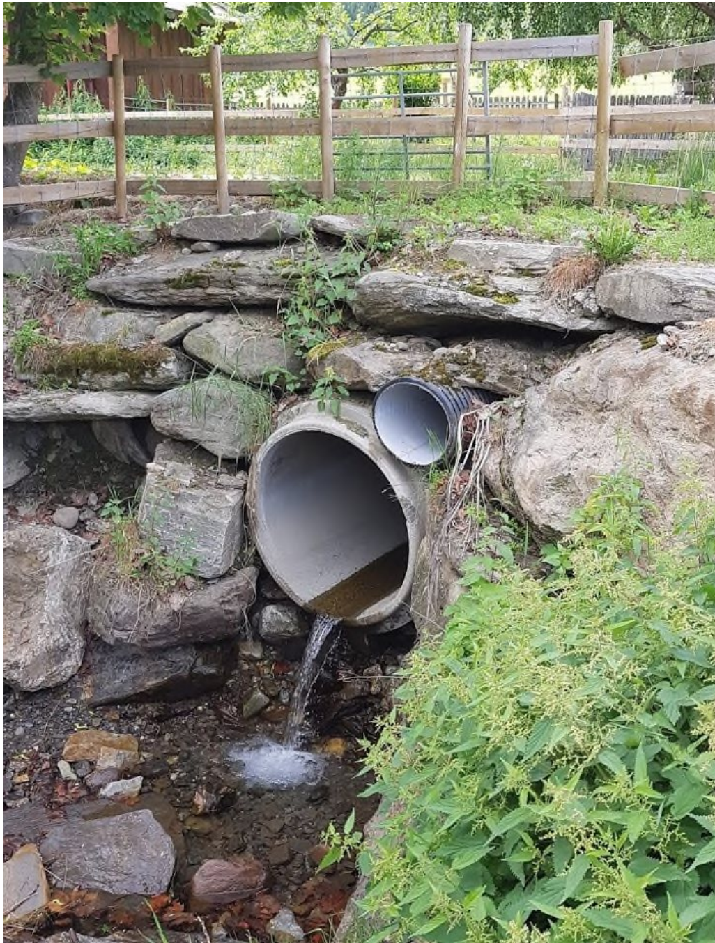
Bilde 86: Utløp tettet stikkrenne ved Sygard Skurdal
