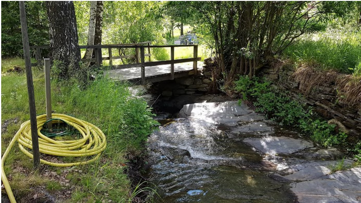
Bilde 66: Bilbru inn til hytte nedstrøms Vintervegen
