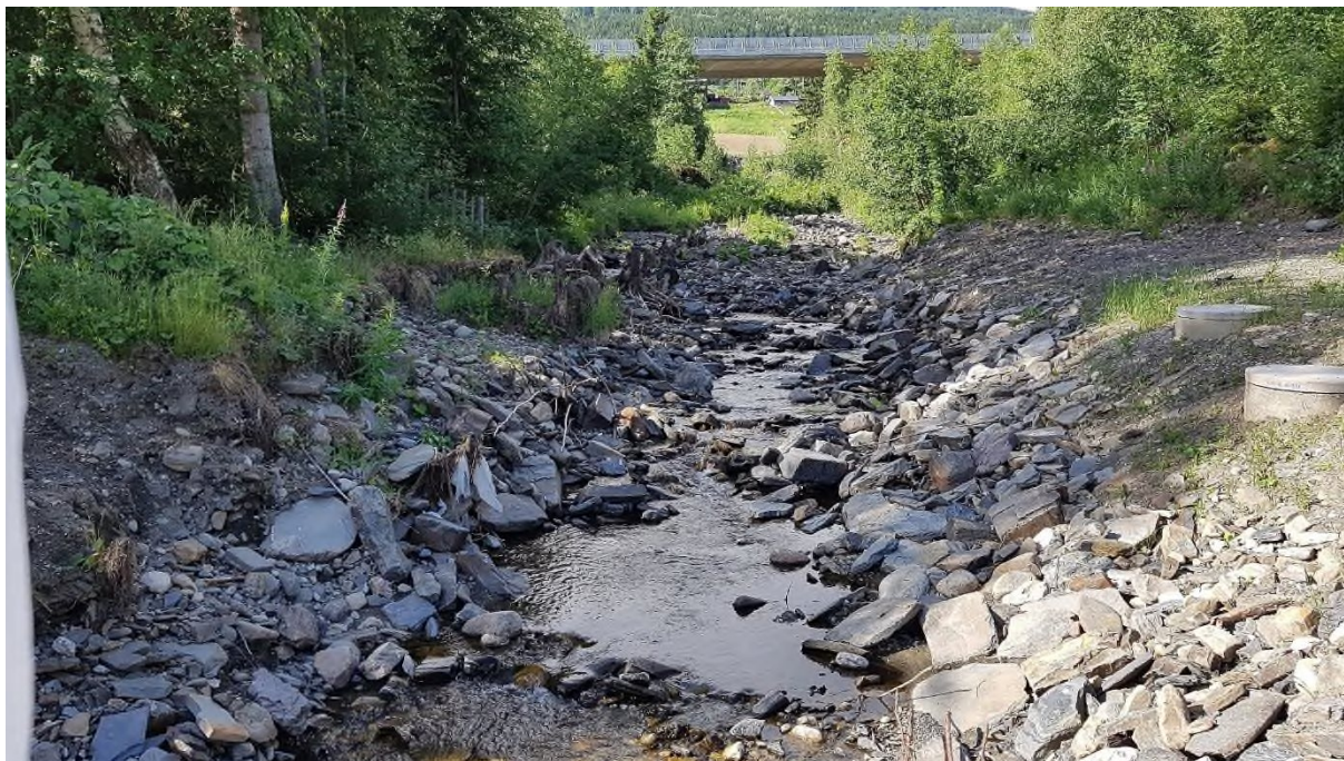
Bilde 73: Oppstrøms bilbru Klokkestranda sett mot E6-brua.
