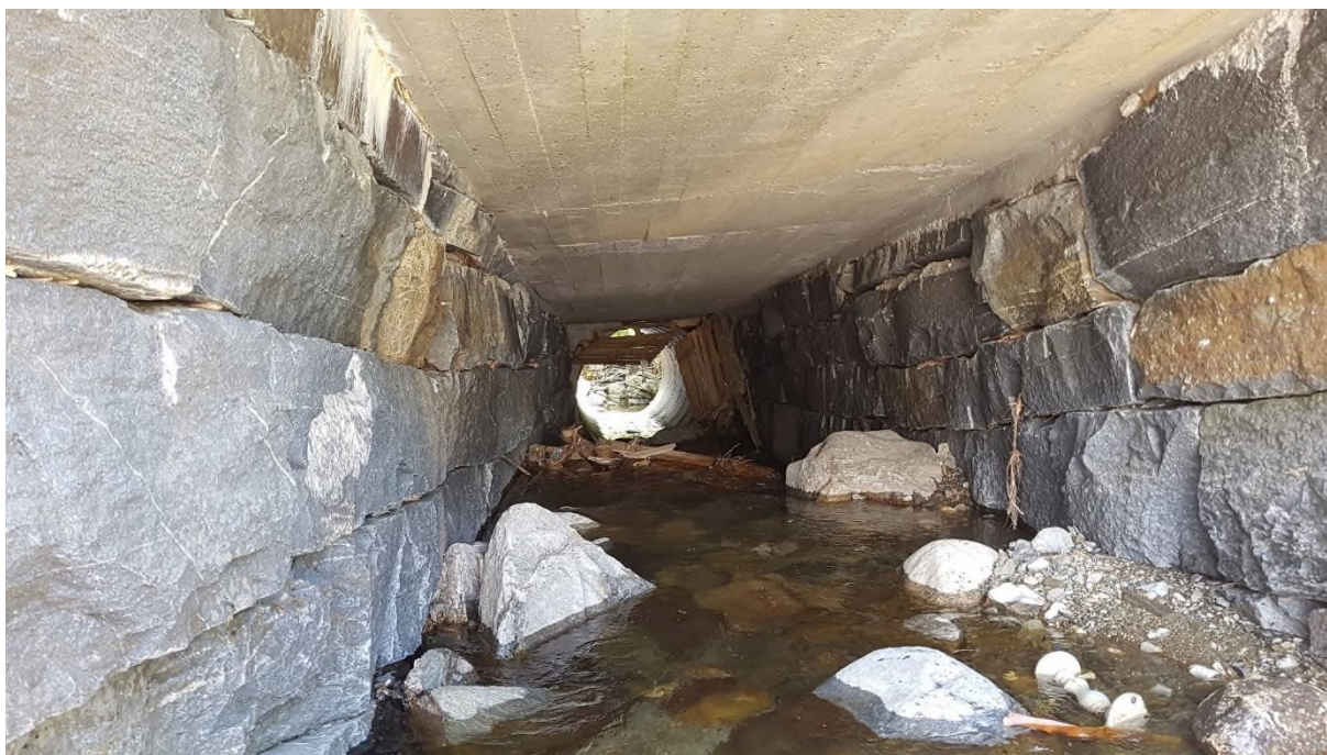
Bilde 28: Kulvert vegkrysning Dålåstigen 467
