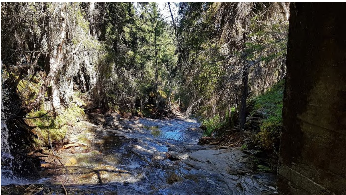
Bilde 21: Nedstrøms utløp vegkrysning Baukholstulvegen 158
