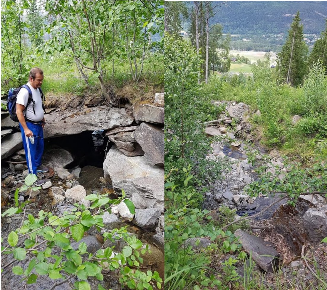
Bilde 79: Viser krysning av traktorveg ovenfor Gålåvegen. Innløp til venstre og utløp til høyre.
