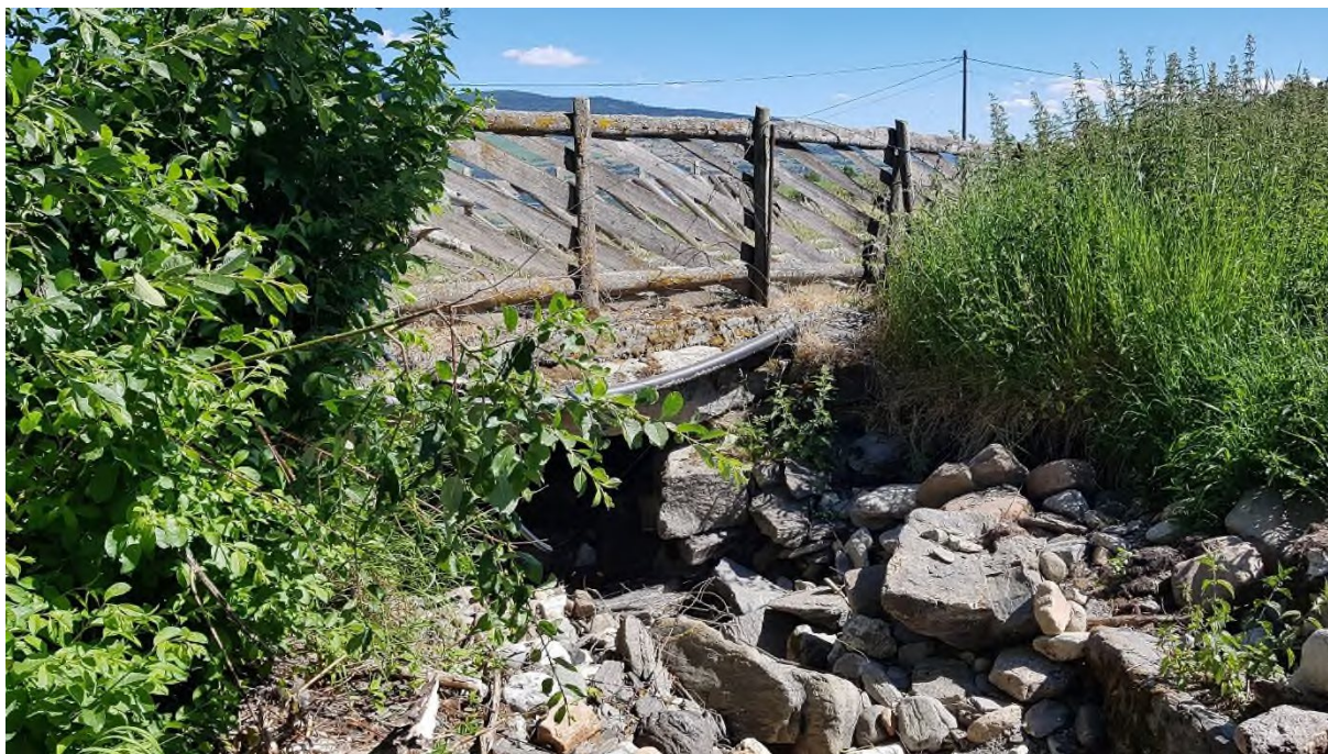
Bilde 82: Innløp vegkrysning gårdsveg oppstrøms Baksidevegen
