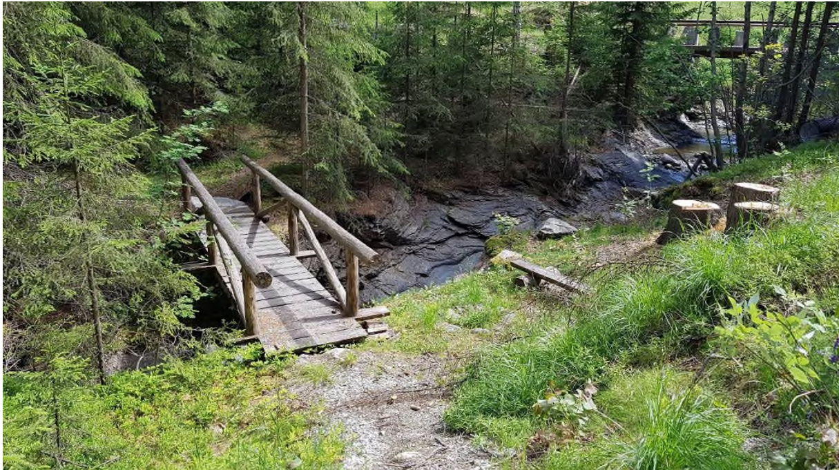
Bilde 41: Gangbru over Skurdalsåa rett nedstrøms Gammelskulevegen
