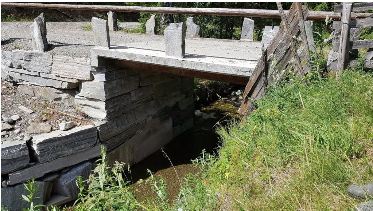
Bilde 38: Innløp bilbru i Gammelskulevegen
