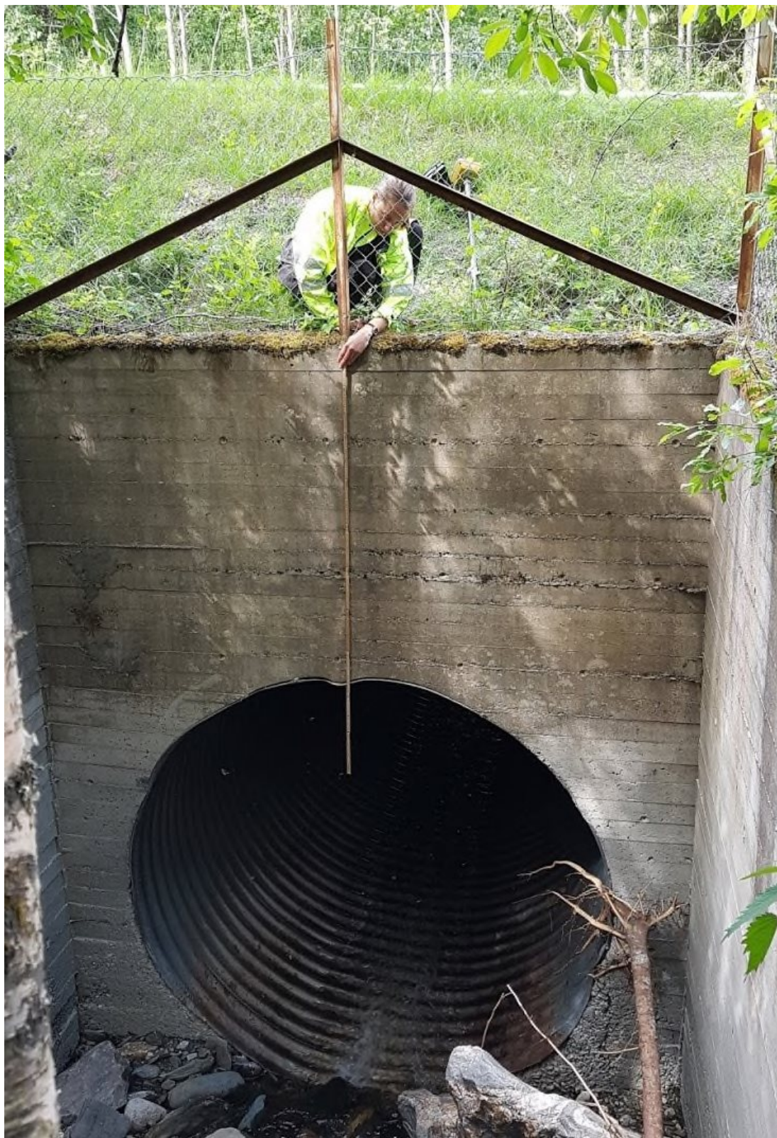
Bilde 23: Innløp vegkrysning Gålåvegen
