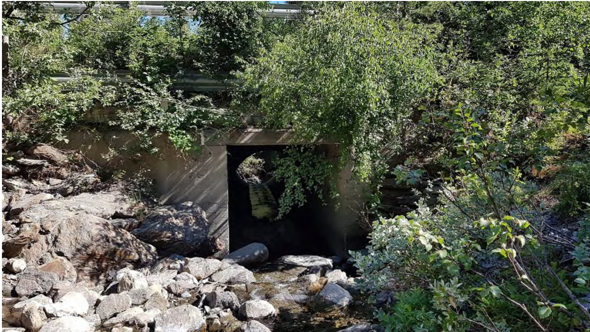
Bilde 16: Innløp kulvert vegkryssing Baukholstulvegen
