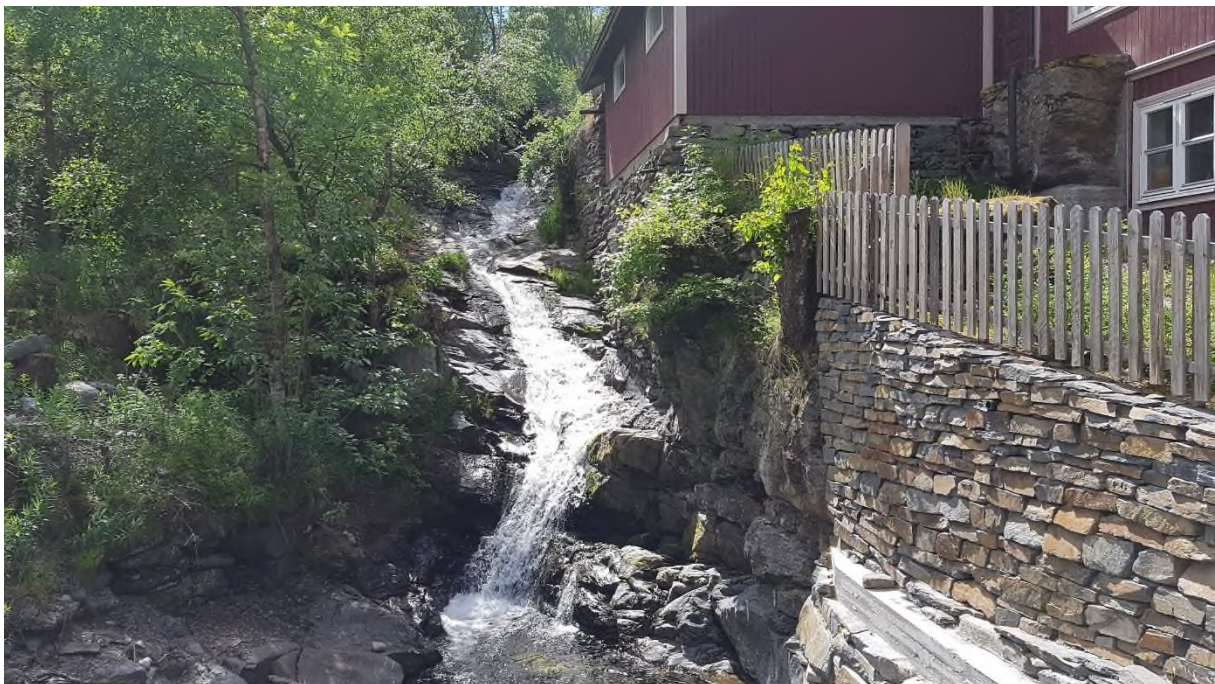
Bilde 48: Oppstrøms vegkrysning Baksidevegen
