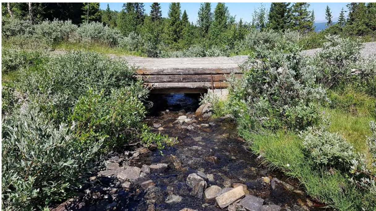
Bilde 3: Trebru øverste vegkrysning av Baukholstulvegen, sett fra oppstrøms side
