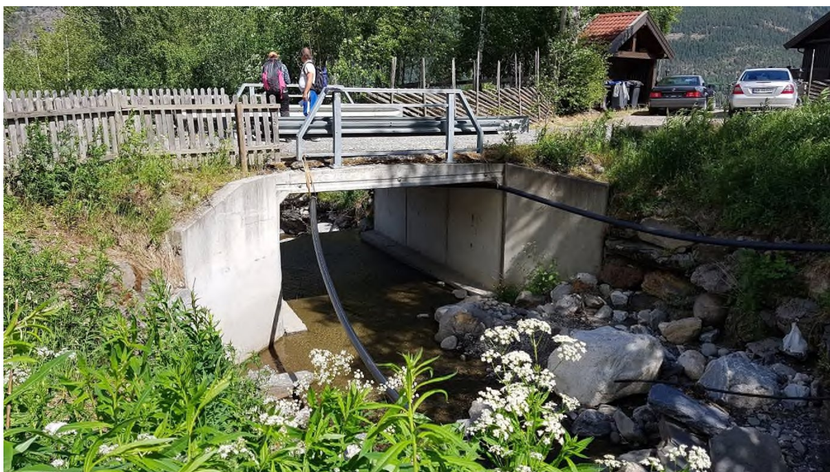
Bilde 45: Kulvert ved vegkrysning Gammelskulevegen
