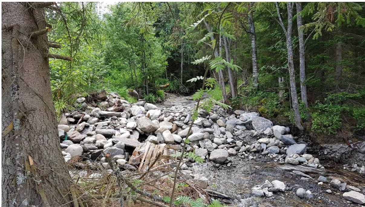
Bilde 31: Brønn for oppdemning til privat brønn ved Larsbakken.
