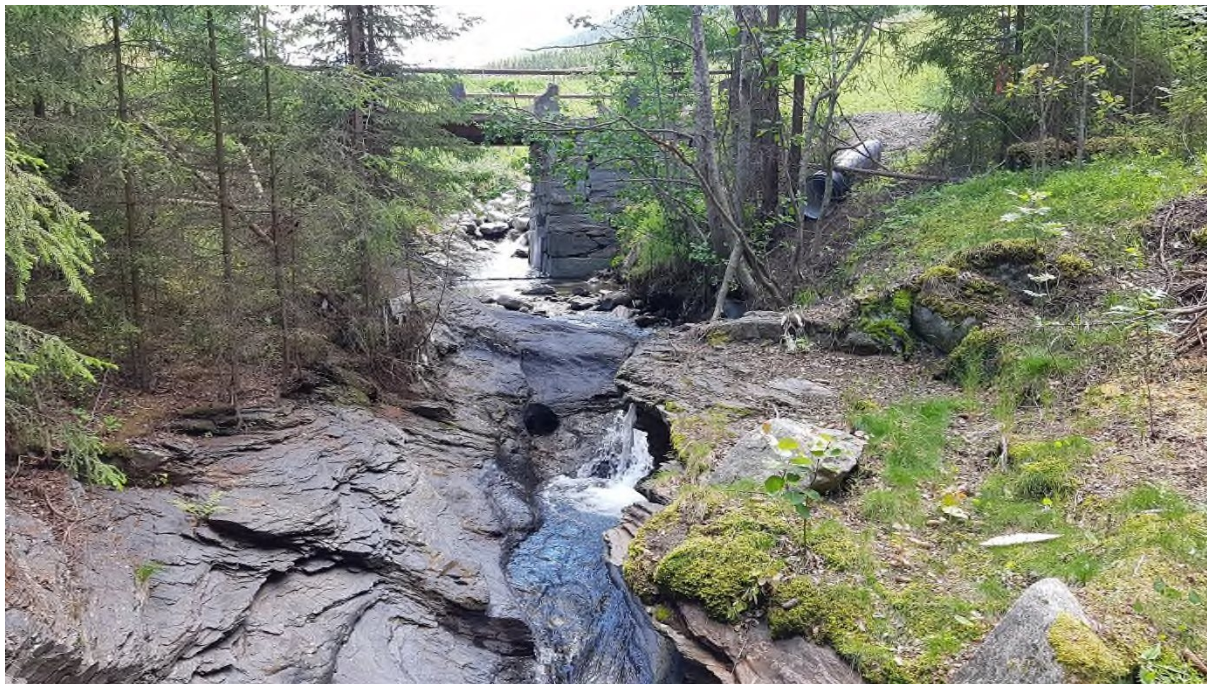
Bilde 39: Nedstrøms vegbru Gammelskulevegen, sett fra gangbru
