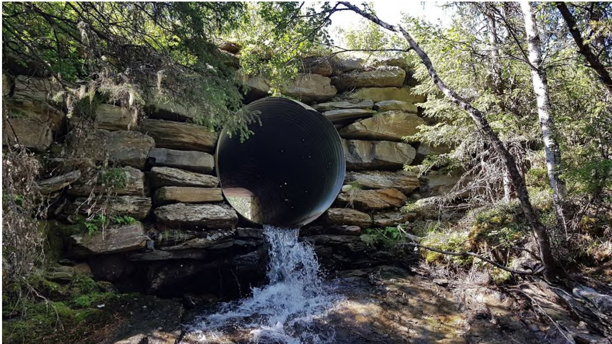
Bilde 17: Utløp vegkrysning Baukholstulvegen
