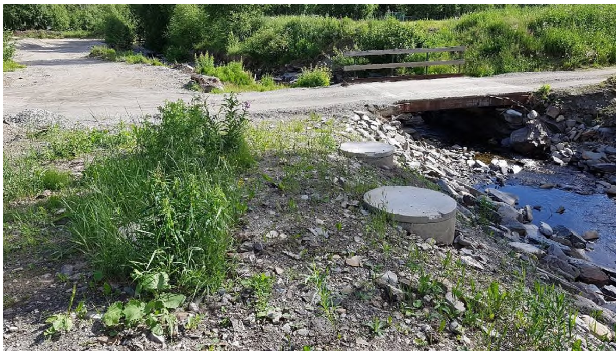
Bilde 74: Vegbru Klokkestranda og parkeringsområde sett oppstrøms fra
