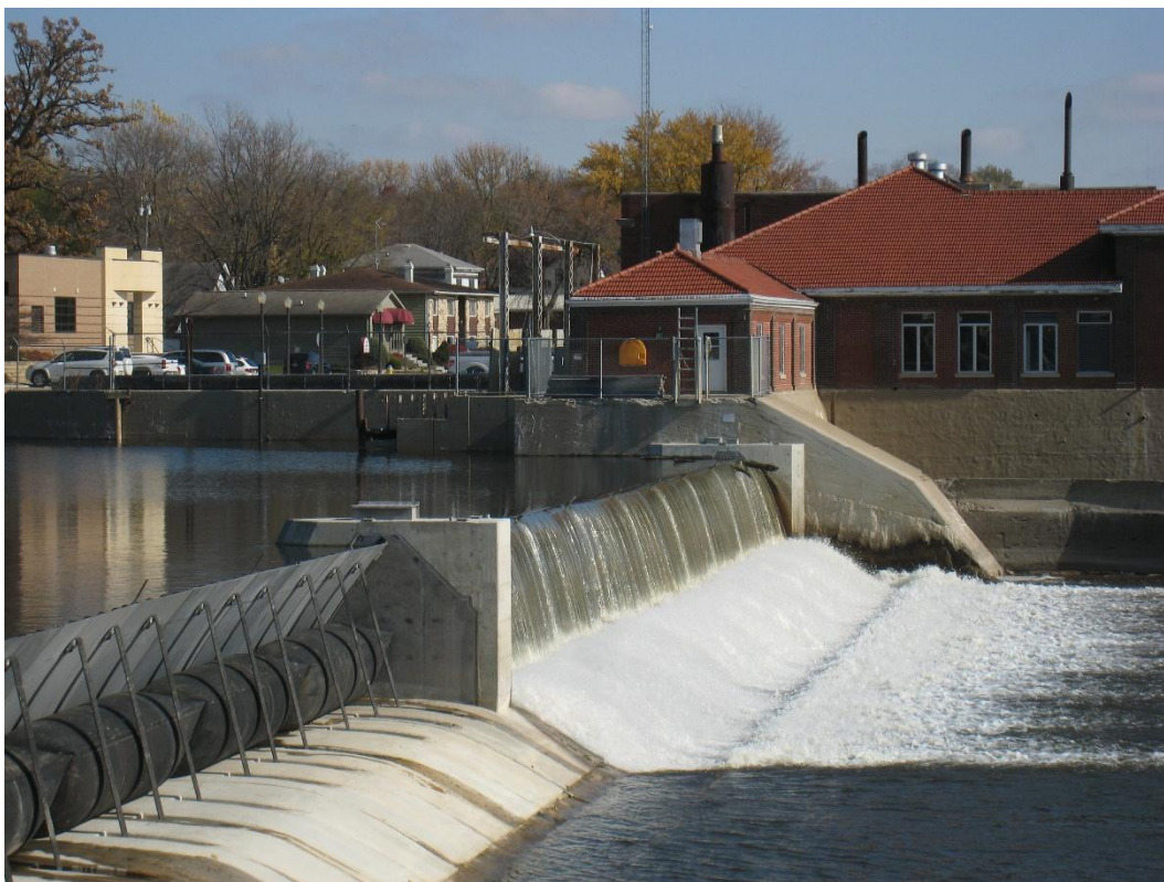
Figur 1: Obermeyer luke. Ved venstre luke kan den oppblåste gummipølsen sees med lukebladet liggende over. Luken til høyre er noe senket slik at vann renner over (foto: Obermeyer Hydro, Inc.)
