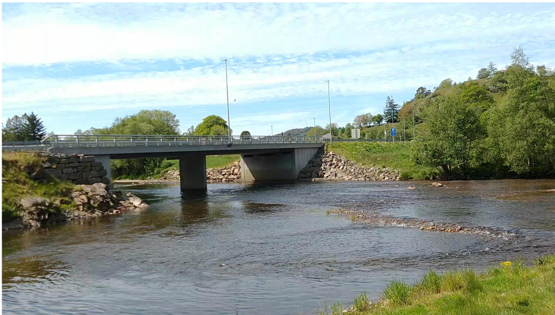
Figur 3.7: Foto av bru nr.: 5 sett fra oppstrøms side. Laveste høyde underkant bru 11,0 Foto: Samuel Vingerhagen
