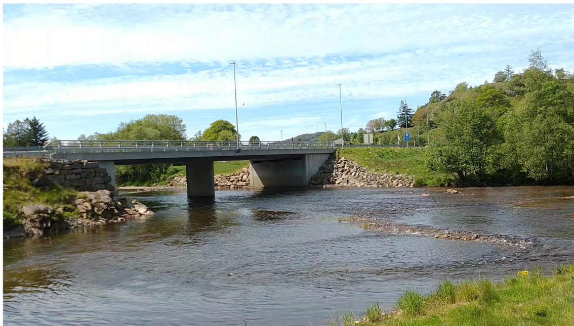
Figur 3.6: Foto av bru nr.: 5 sett fra oppstrøms side. Laveste høyde underkant bru 11,0 Foto: Samuel Vingerhagen
