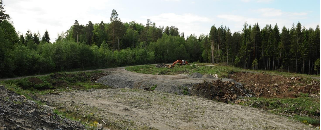
Figur 44-35. Området sør for Stortjern hvor grunneieren har fått tillatelse til nydyrking. Det er Arendal kommune som deponerer masse i forbindelse med planering av arealet. Planlagt benyttet som riggplass, ca. 150 m fra ledningene.
