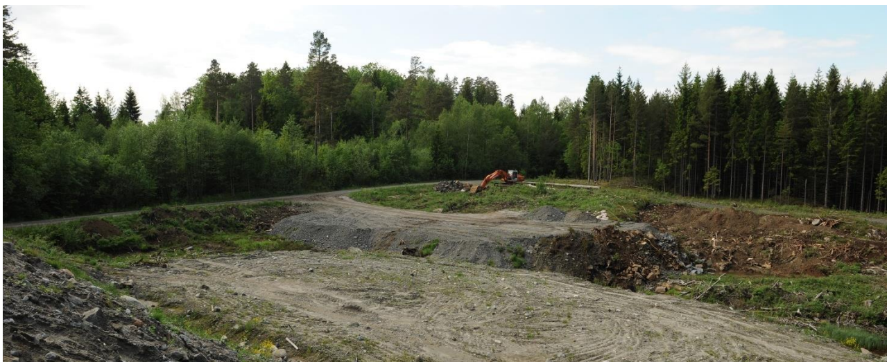
Figur 4-16. Området sør for Stortjern hvor grunneieren har fått tillatelse til nydyrking. Det er Arendal kommune som deponerer masse i forbindelse med planering av arealet.
