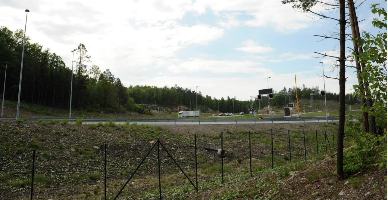
Figur 4-18. E18 i sørenden av delområdet dominerer dette partiet og bryter med landskapets opprinnelige skala.
