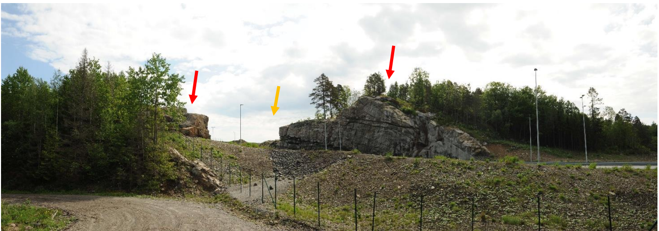
Figur 4-36 Dagens ledning som skal rives og legges om er indikert med oransje pil. De to nye ledningen og omlagt ledning vil krysse over veien fra de to fjellskjæringene (indikert med røde piler) og ende i Eyde koblingsstasjon på baksiden av kollen midt i bildet.
