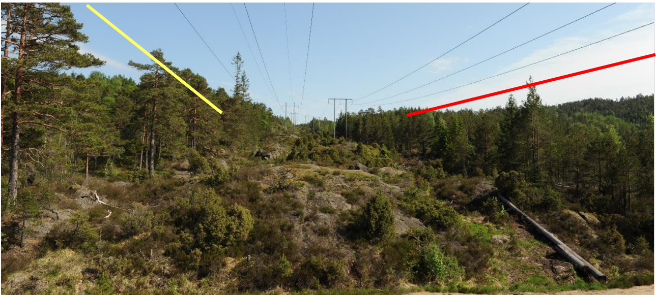
Figur 4-24. Bilde fra grusvei i skogen vest for Siring stall, som vanligvis er sperret med bom for uvedkommende. Ledningene midt i bildet er dagens 132 kV- og 66 kV- ledninger (hhv. til venstre og høyre). Løsning 1 (rød) og 2 (gul) parallellføres på hver sin side av dagens ledninger, hver av løsningene vil medføre et samlet ryddebelt med bredde på ca. 100 meter.
