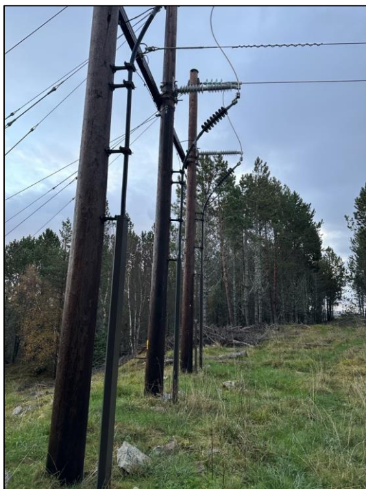
Figur 2. Bilde av dagens kabelnedføring ved endemaste i Dolmsundet.
