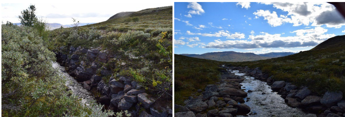
Figur 25 Venstre: Kanalen er gravd dypere i terrenget enn den naturlige utløpselva, og kantene på kanalen er stedvis murt med tørrmur de første 120 metrene. Høyre: Kanalen etter myra, her er den enkel å krysse. Foto: Siri Wølneberg Bøthun.
