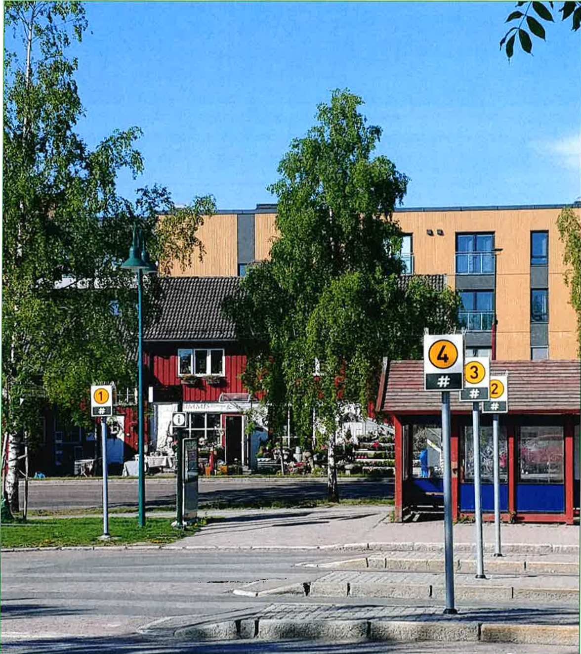
Bilde 1 Ask terminal – fotograf Helge Karl Nyhamn, Gjerdrum kommune - 28/05/2018
