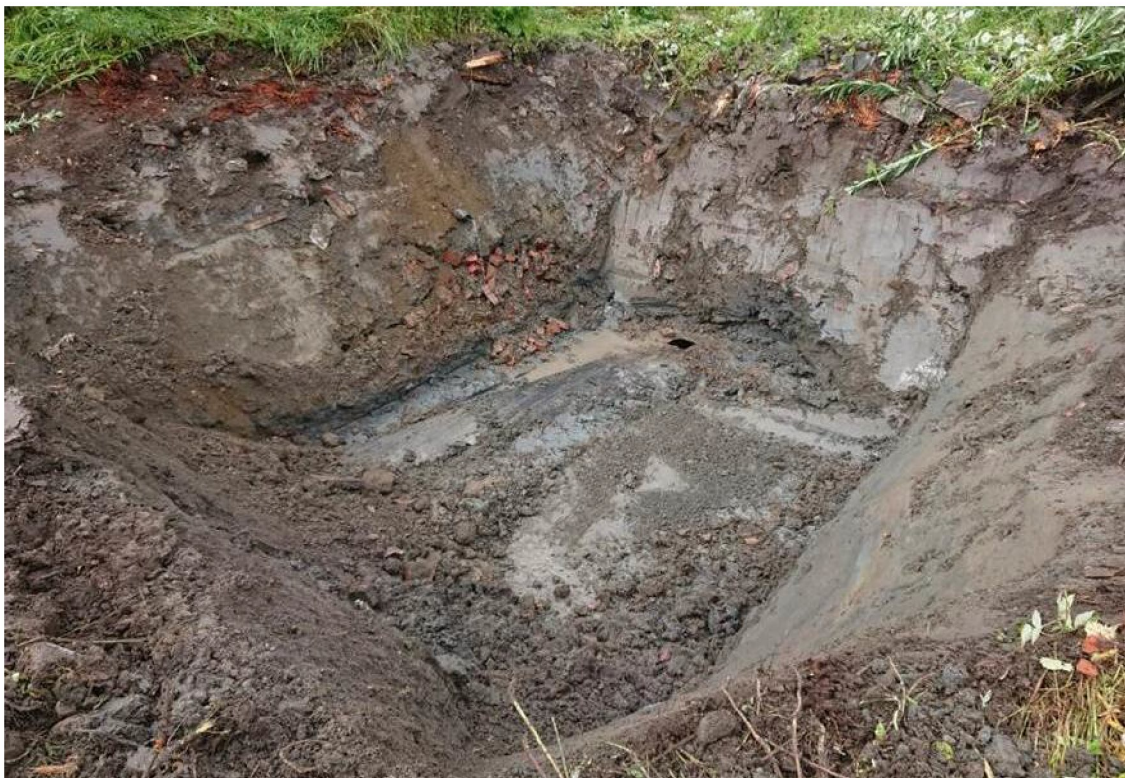
Figur 2: Sjakt nr. 1 utgravd ned til topp av eksisterende rør på ca. kt. + 16,62
