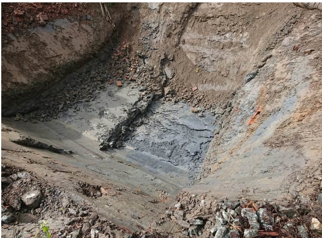
Figur 3: Sjakt nr. 2 utgravd ned til traubunn på ny rørtrasé, ca. kt. + 16,06.
