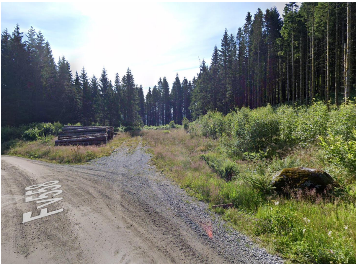
Figur 30 - Rørlager, sett fra kryss der Fivelandsveien går av. Området settes tilbake i den stand grunneier ønsker. Eksakt andel som blir bestående som lunneplass avtales underveis i prosjektet med NVE på tilsyn, samt i samråd med grunneier.
