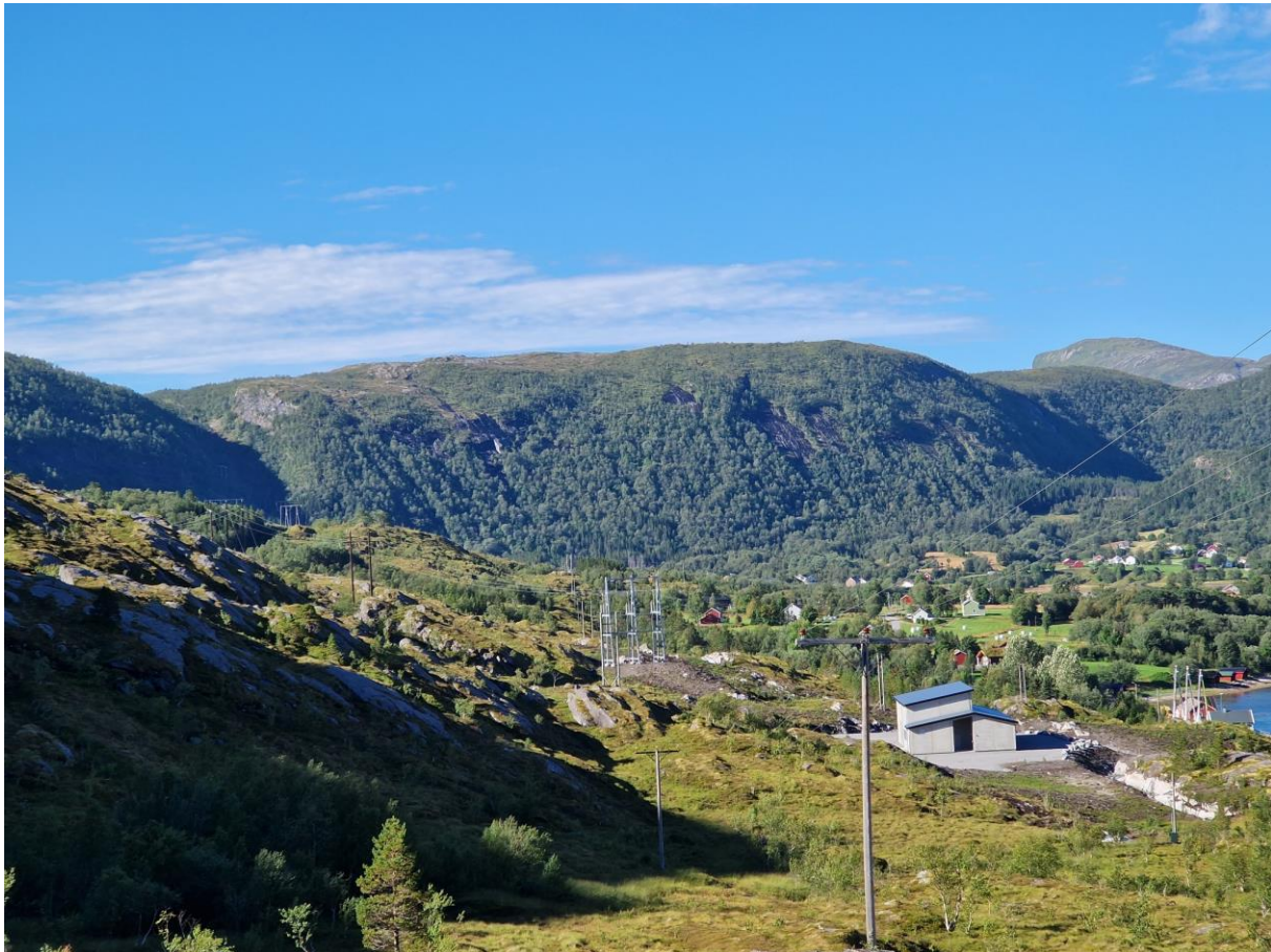
Figur 5-11. Nye Kjelling transformatorstasjon med tilkobling til eksisterende 132 kV-kraftlinje ligger midt i flyttleia mellom Evja og Indre Kjelling. (Foto: Sweco Norge AS)
