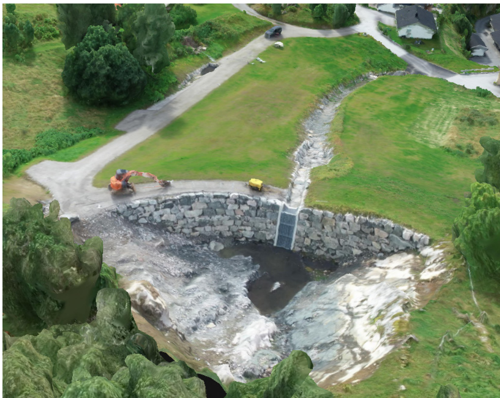
Figur 3-9 Oversiktsbilde av fangvoll og massebasseng i Skagekleiva (NVE).
