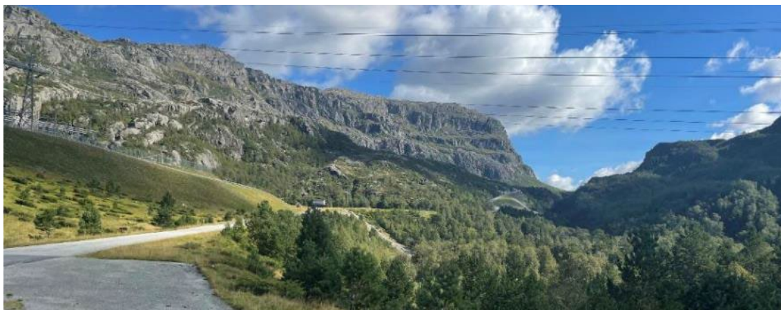
Figur 4-3 Saurdal kraftverksett fra Kjetilstadvegen mot sørøst
