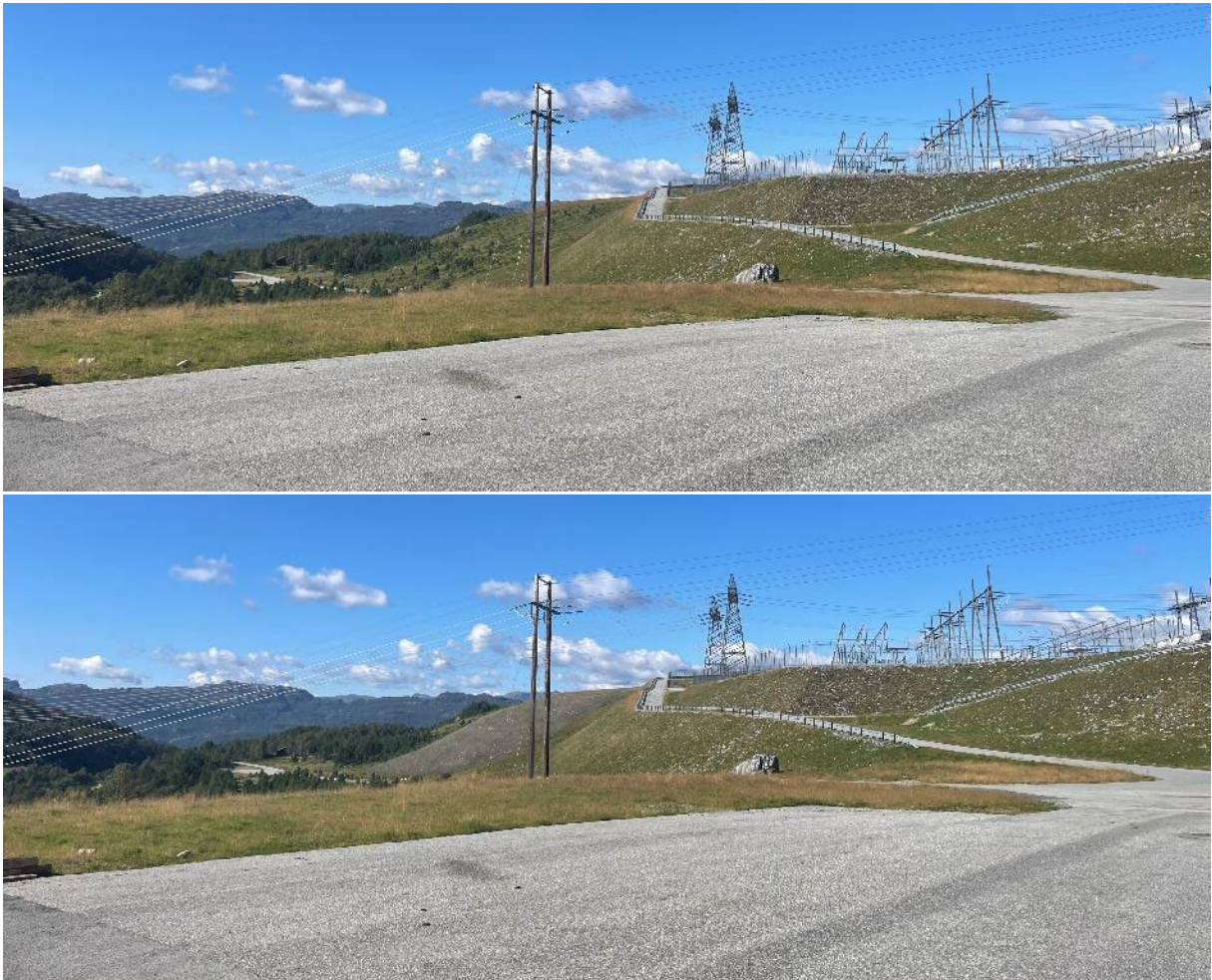
Figur 9-5 Masselagerområdet med før situasjon øverst, og visualisering av masselager Vest etter utfylling og tildekking med toppmasser. Området vil revegeteres naturlig fra frøbank i toppmassene og med innvandring av vegetasjon fra tilstøtende områder etter hvert.
