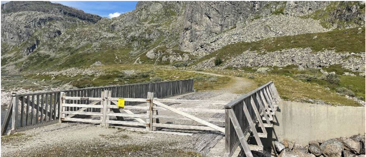
Figur 10-11 Eksisterende bro over Oddåa oppgraderes og benyttes i anleggsfasen.
