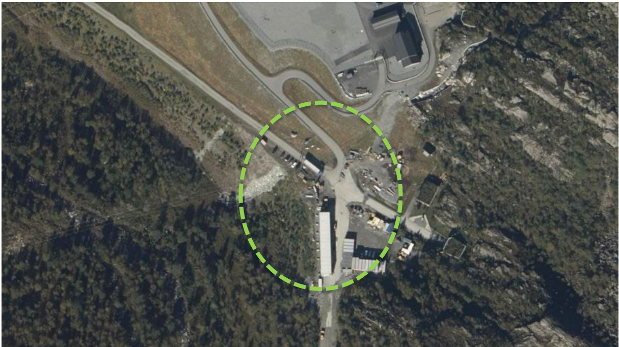
Figur 9-2 Riggområde ved Saurdal kraftverk fra anlegget i 2019, fra historiske kart på finn.no
