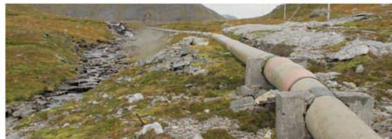
Figur 4. Her er vi litt nedanfor demninga i Litlevatnet i nærleiken av inntaket og ser oppover elva. Biletet viser i tillegg til elva, den eksisterande røyrgetraséen i området. Vegetasjonen er prega av lågt rabbesamfunn og myrområde med innslag av artar som røsslyng, fjellmarikåpe, rone og blokkbær. (Foto; Oddvar Olsen, 28.09.2012 ©).
