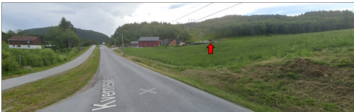
Figur 87: Bilde, fra nord mot sør, som viser plassering av nye Bruvoll transformatorstasjon (rød pil) fra Kvernesveien. Til venstre (øst) for nye Bruvoll transformatorstasjon ses eksisterende Bruvoll transformatorstasjon (gult bygg) og Averøy brannstasjon (rødt bygg), og til venstre for Kvernesveien ses nærmeste bolig mot øst. Kilde: Google Street View.
