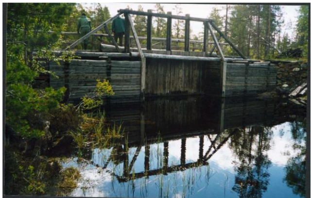
Figur 10 viser Tømmerkistedam i Kalddalselva.
