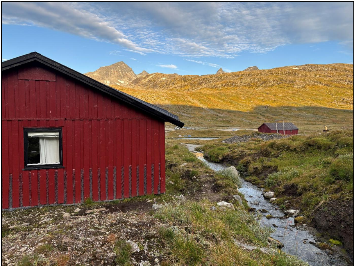
Figur 13: Bekk som drenerer fra vest inn i sørlig del av kartleggingsområdet har gitt skader på bygg. Dette bygget er merket som infopunkt 1 i registreringskartet.
