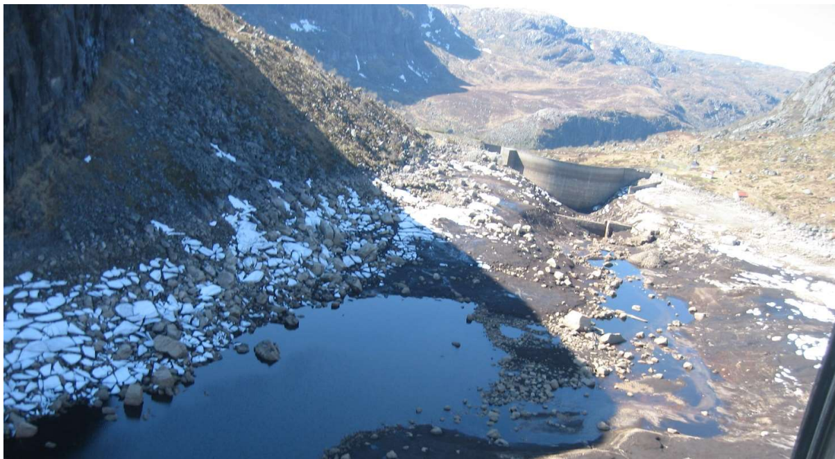
Bildet viser Myrtjern ved senkningen i 2010 og viser at det i praksis ikke er mulig å senke Myrtjern ytterligere. Logg fra senkningen i 2010 viser at vannstanden på det aktuelle tidspunktet var 585,9.
