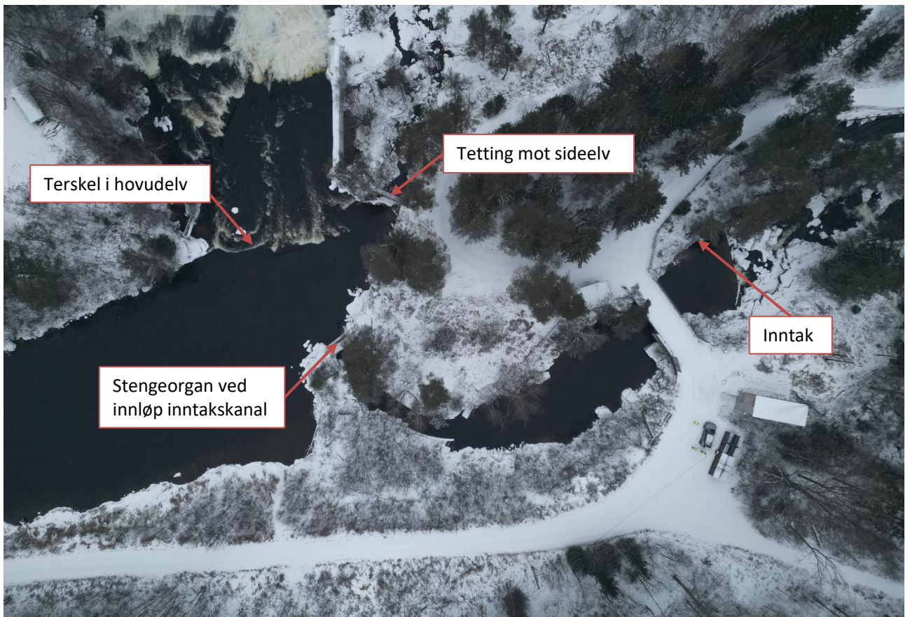
Dronefoto av øvre del av utbyggingsområdet. Eksisterende komponentar blir utbetra.
