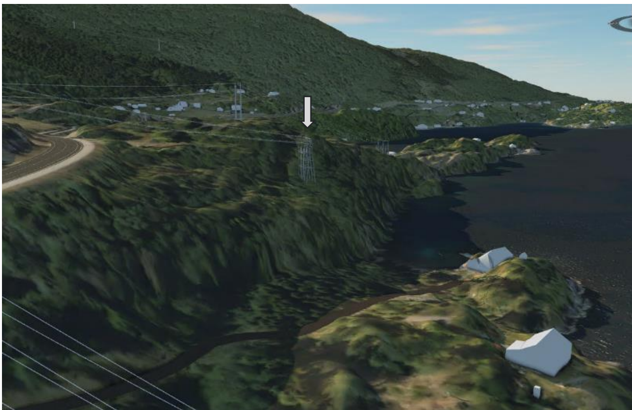
Figur 6-20 Kabelendemast 2.1 ligger tett på to hytter i Kalhagevika.
