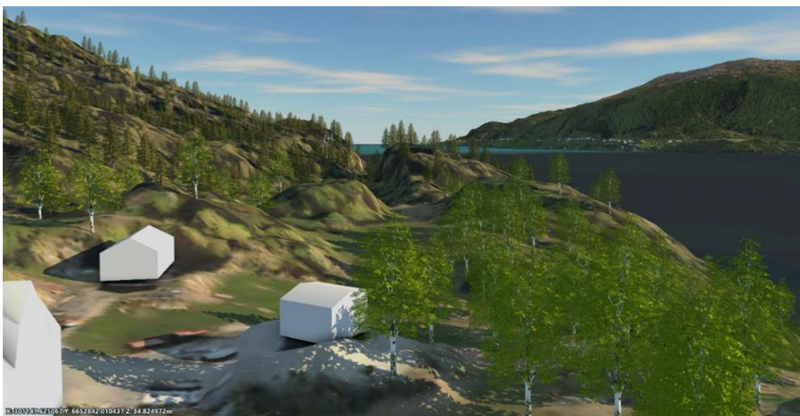
Figur 6-42 Utsnitt av modell fra nærmeste gårdsbruk. Kabelendemast og ledning vil på grunn av terrengformer og mye vegetasjon i området, bli lite synlig, om noe, sett fra bebyggelse
