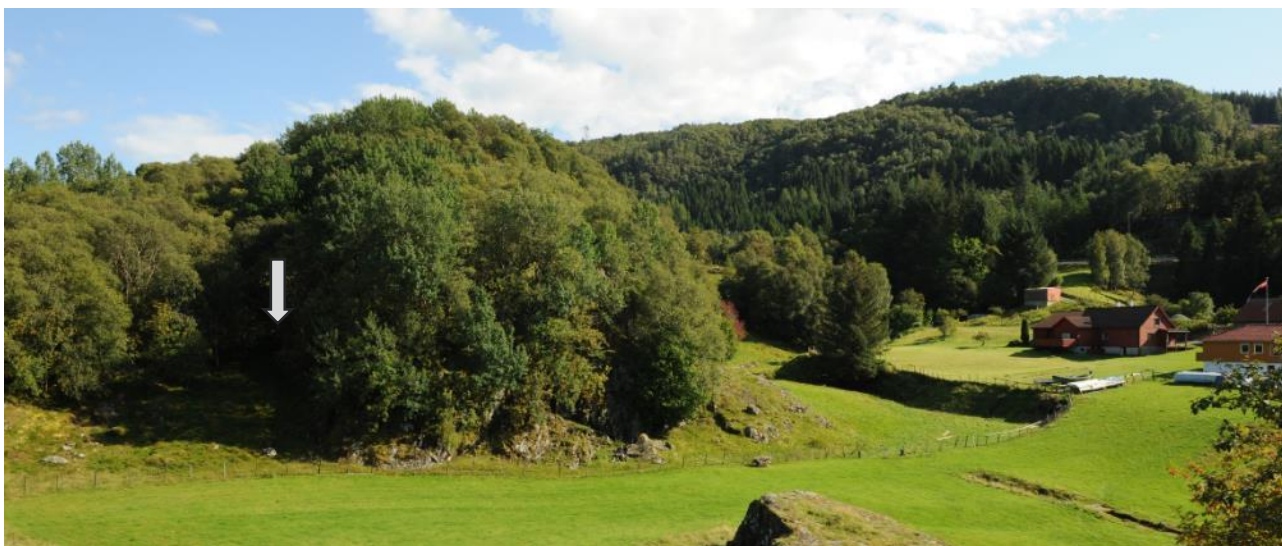
Figur 6-18 Kablendemasta i alternativ 2.0 ligger godt skjult bak en kolle, sett fra bebyggelse.
