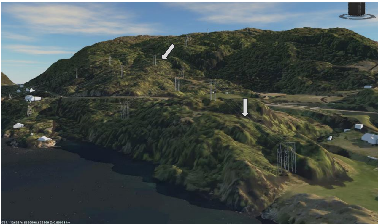
Figur 6-14 Alternativ 2.0 ligger godt plassert i terrenget med god bakgrunnsdekning på oversiden av veien, og med størst avstand til bebyggelse av alternativene på østsiden av Vistvikevågen.
