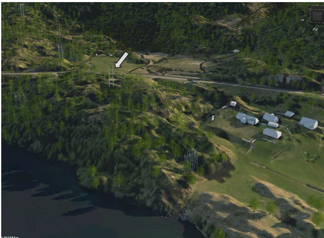
Figur 6-15 Kabelendemast og kabelgrøft ligger godt plassert i terrenget, men nest siste mast står synlig til på toppen av kollen.
