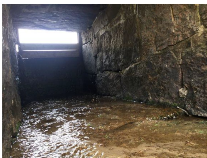
Til høyre, nederste åpning (med rørgjennomføring) og til høyre, åpning for overvann med planker for nivåkontroll.
