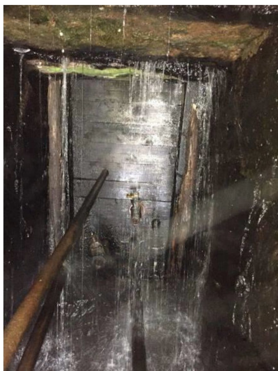
Til høyre, nederste åpning (med rørgjennomføring) og til høyre, åpning for overvann med planker for nivåkontroll.
