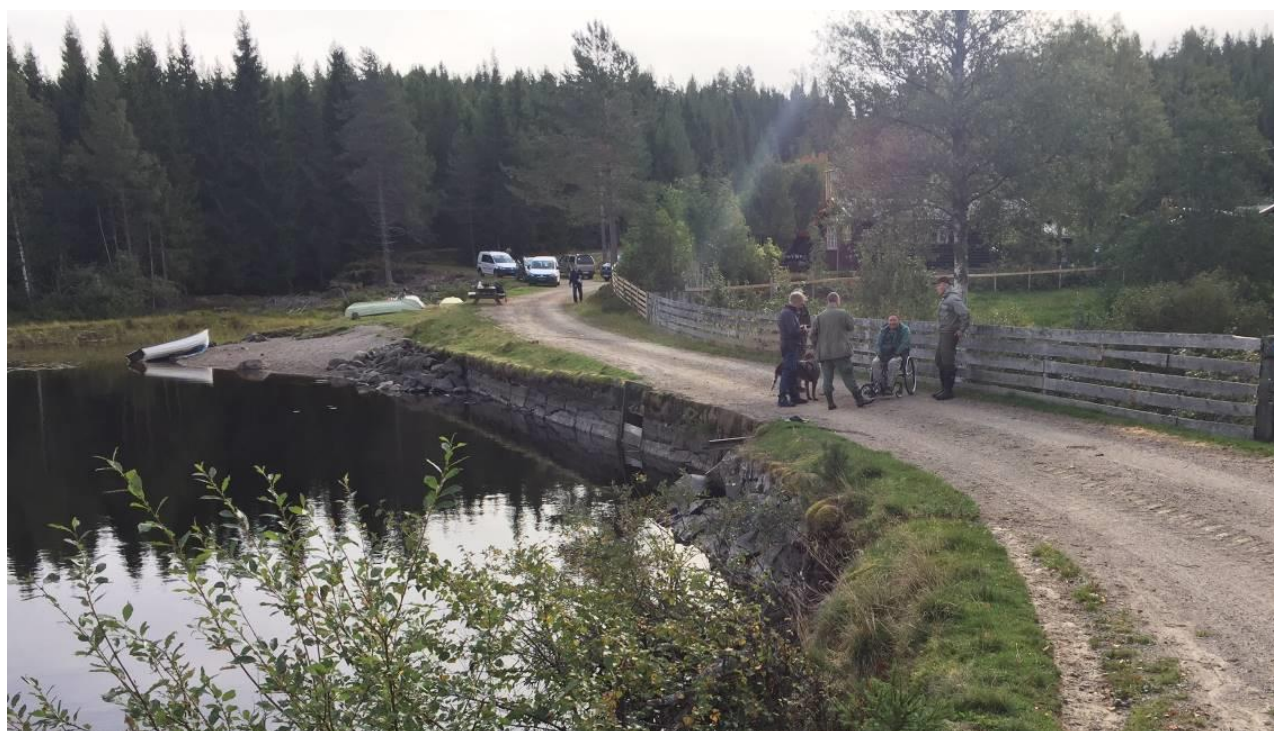
Foto av dammen. 12 meter tørrmur med store steiner i sentrum, sidekanter med jord og steinsatt front og nedstrøms. Vannivå er 1,06 m under vegen på befaringsdagen (14.09.2018).
