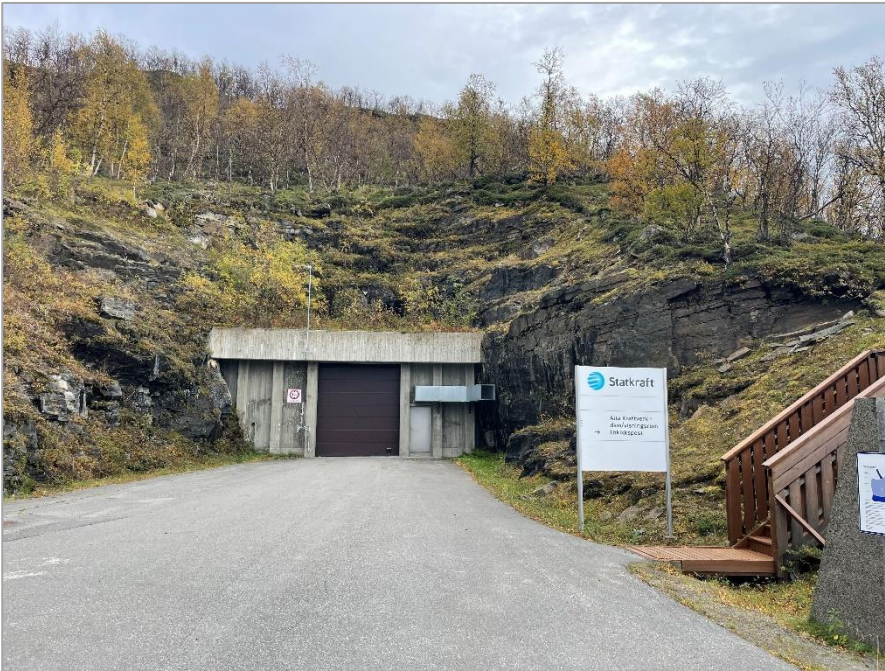
Figur 3-2. Bildet viser inngangen til inntaket og demningen. Til høyre i bildet vises trapp til utkikkspunkt. Foto: Sweco
