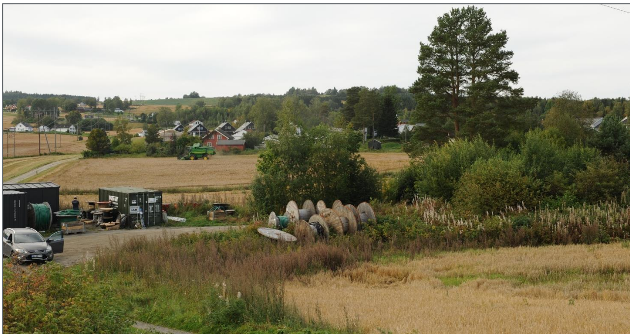
Figur 5-10: Bildet er tatt ved Kongsengen transformatorstasjon med deler av bebyggelsen på Sletta i bakgrunnen.
