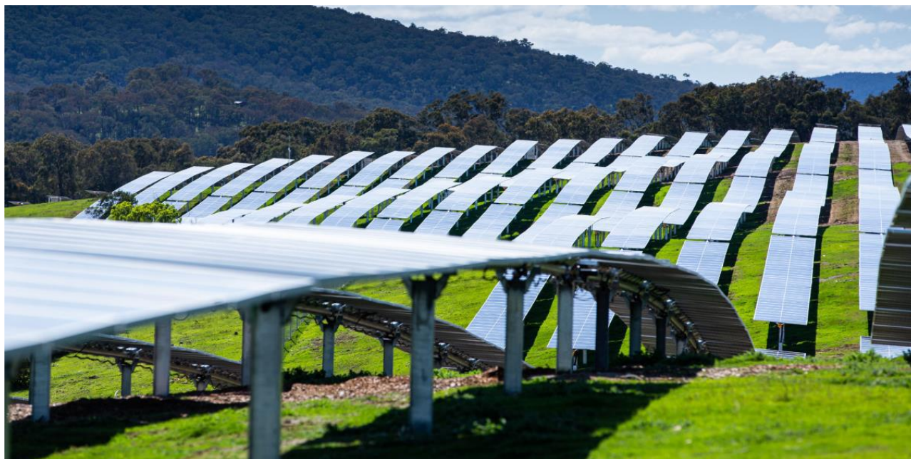
Figur 3-2 Illustrasjonsfoto av trackersystem. Foto: Nextracker
